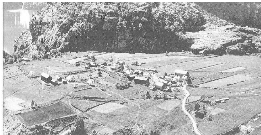
Figur 20. Flyfoto frå 1950-talet over Låvi, eit viktig bygningsmiljø med godt inntakt bygningsstruktur. Foto: Telemark flyselskap
