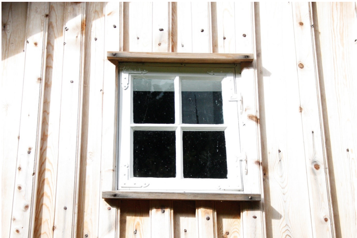
Figur 105. vindauga i gavlen med inngangsdøra. Foto Arlen Bidne/Vestland fylkeskommune, 2022.
