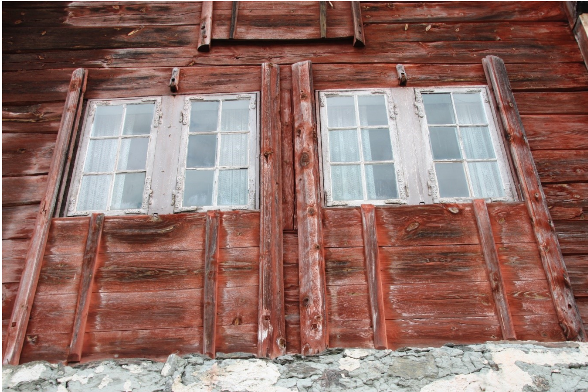
Figur 120. Vindauga i førsteetasje i gavlen mot fjorden. Vindauga er utstyrt med skyvelem. Foto Arlen Bidne/Vestland fylkeskommune, 2022.
