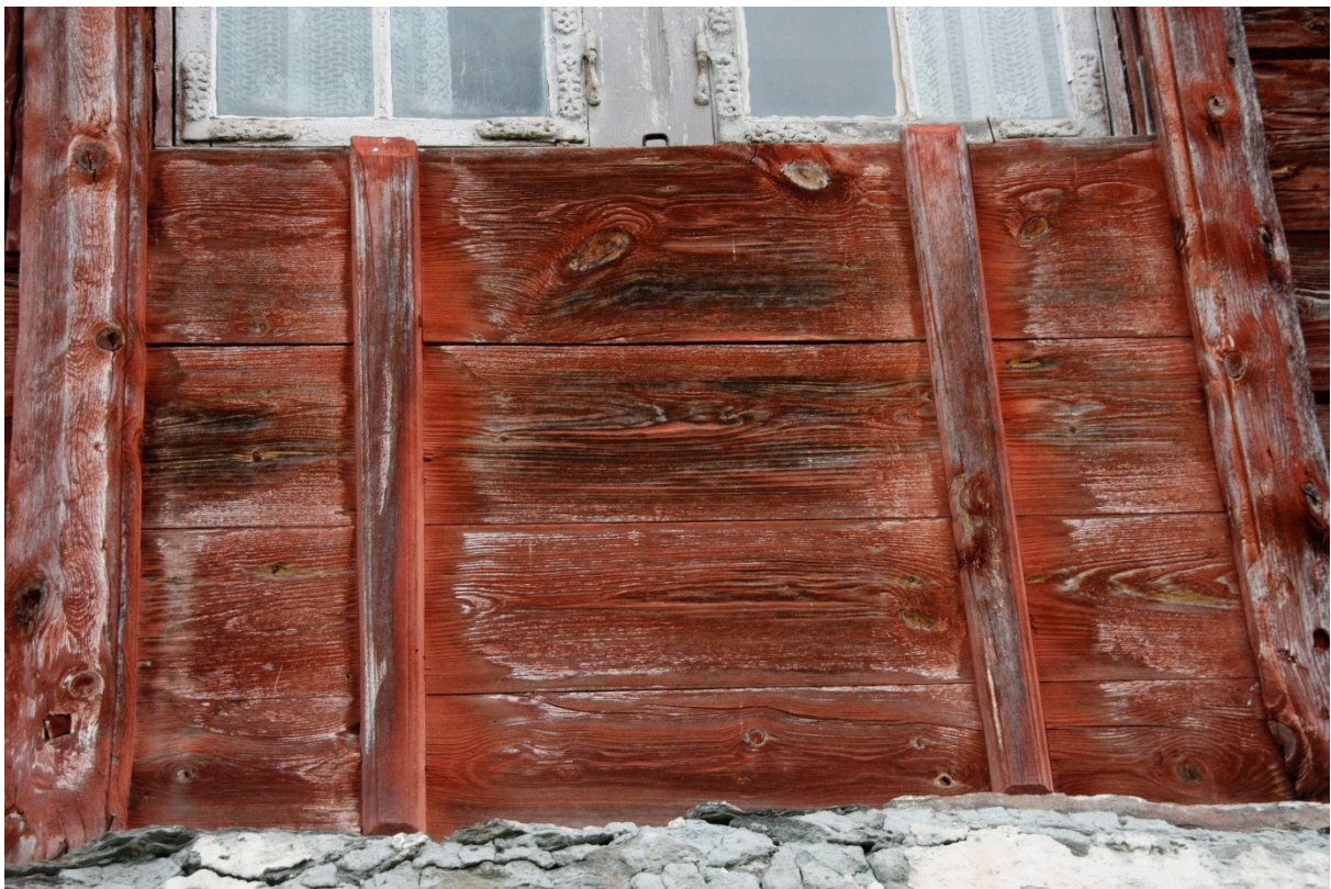
Figur 125. Skyvelem til stovevindauga. Foto Arlen Bidne/Vestland fylkeskommune, 2022.
