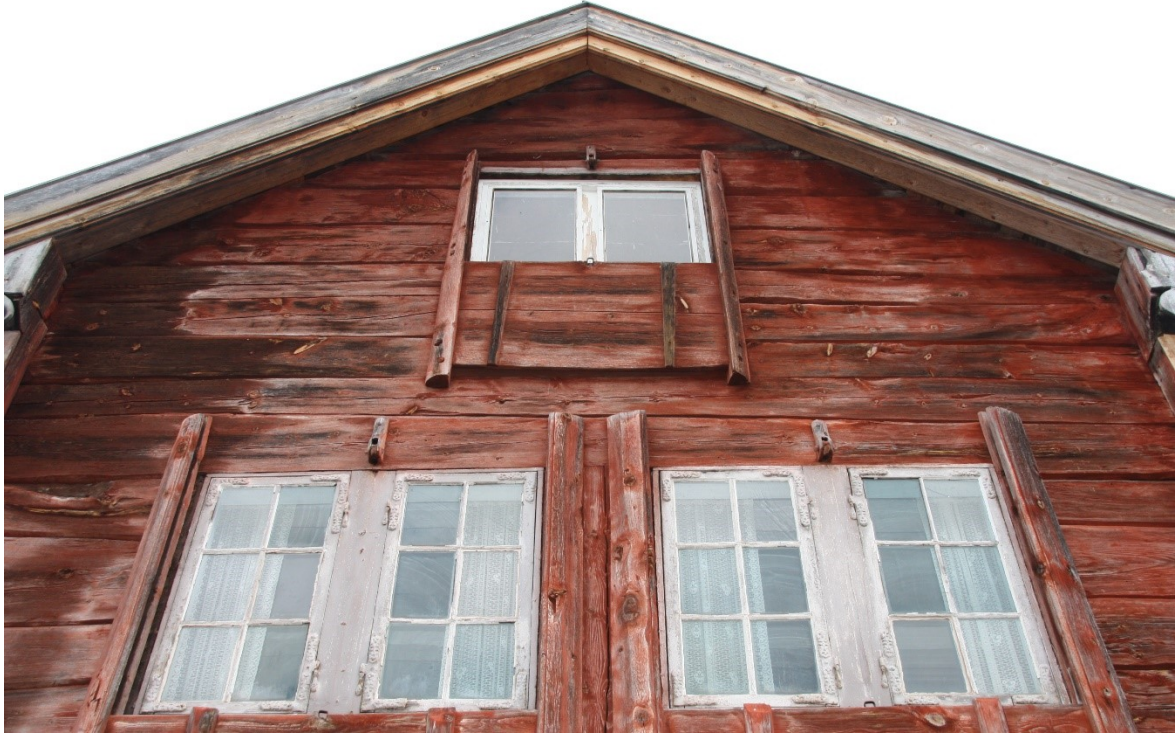
Figur 118. Vindauga med skyvelem i gavlen mot fjorden. Foto Arlen Bidne/Vestland fylkeskommune, 2022.
