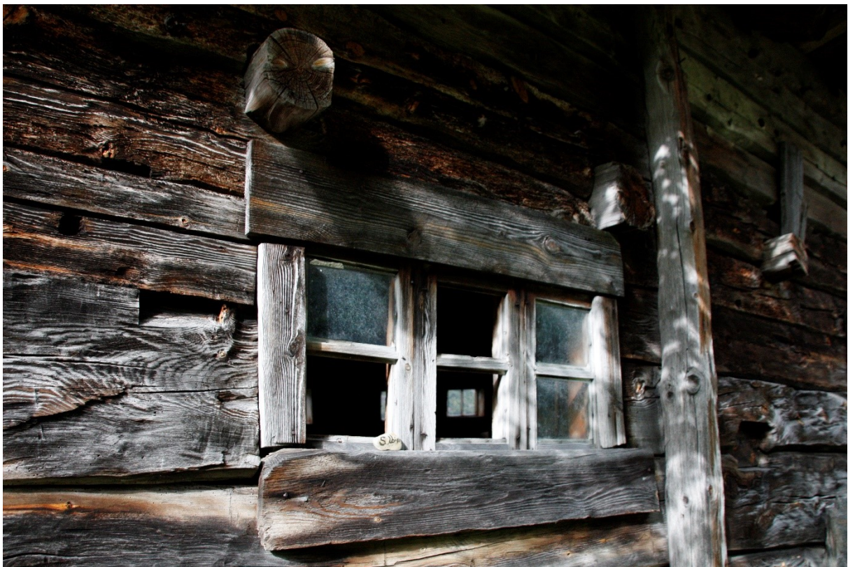
Figur 161. Vindauga til kyrafjøsen, langveggen mot tunet. Foto Arlen Bidne/Vestland fylkeskommune, 2022.
