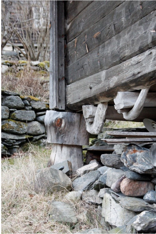
Figur 22. Stabe i bakkant av stabburet. Biletet til høgre viser også litt av steinarbeidet framfor inngangsdøra. Foto Arlen Bidne/Vestland fylkeskommune, 2022.
