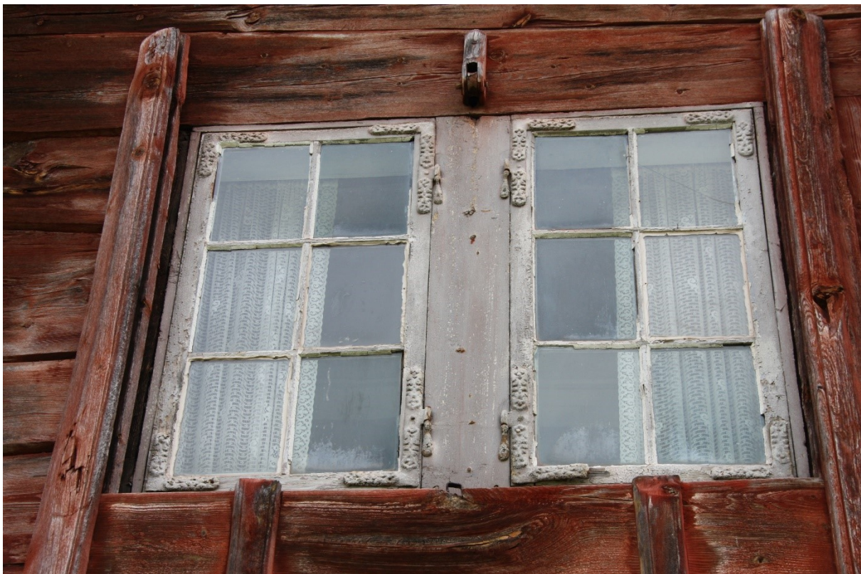
Figur 121. Stovevindauga med dekorerte hengsler. Foto Arlen Bidne/Vestland fylkeskommune, 2022.
