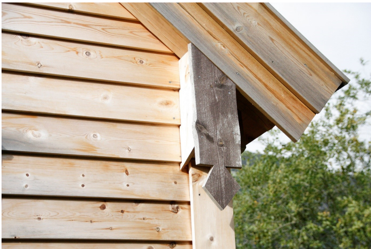
Figur 83. Hengebrett framfor lafteknute i gavlen med inngangsdøra. Foto Arlen Bidne/Vestland fylkeskommune, 2022.
