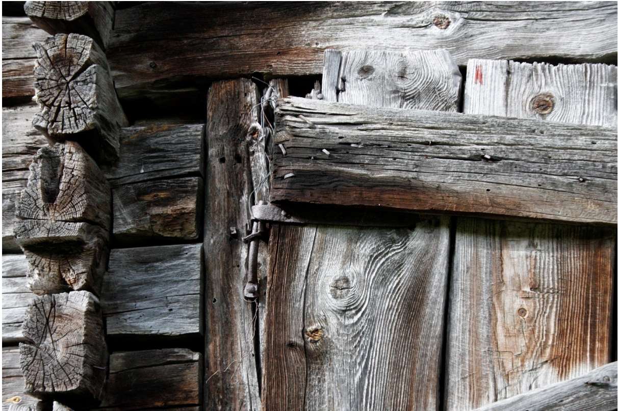
Figur 153. Detalj av hengsle til låvedøra. Foto Arlen Bidne/Vestland fylkeskommune, 2022.
