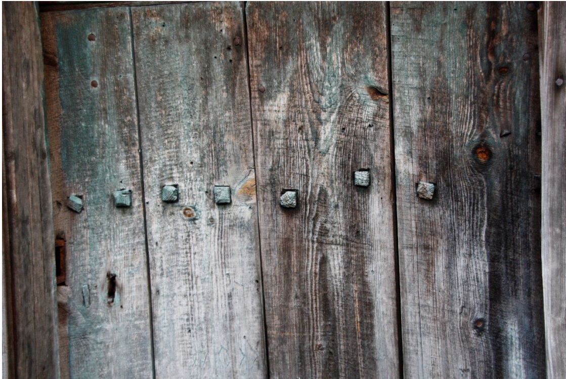
19. Detalj av trenaglane i inngangsdøra. Foto Arlen Bidne/Vestland fylkeskommune, 2022.
