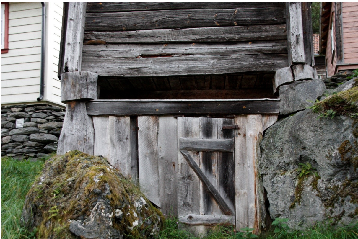
Figur 25. Inngangsdør til kjellar. Foto Arlen Bidne/Vestland fylkeskommune, 2022.
