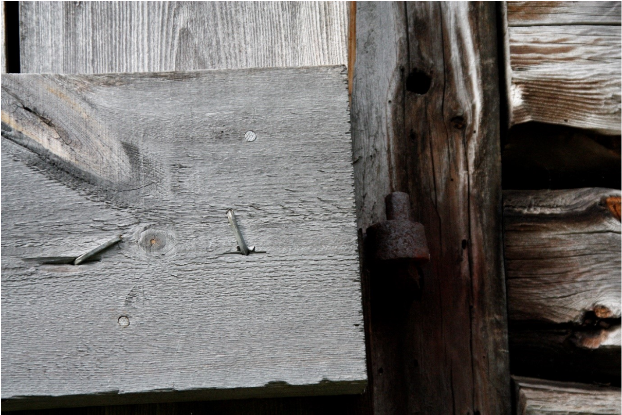
Figur 155. Detalj av hengsle på låvedøra. Foto Arlen Bidne/Vestland fylkeskommune, 2022.
