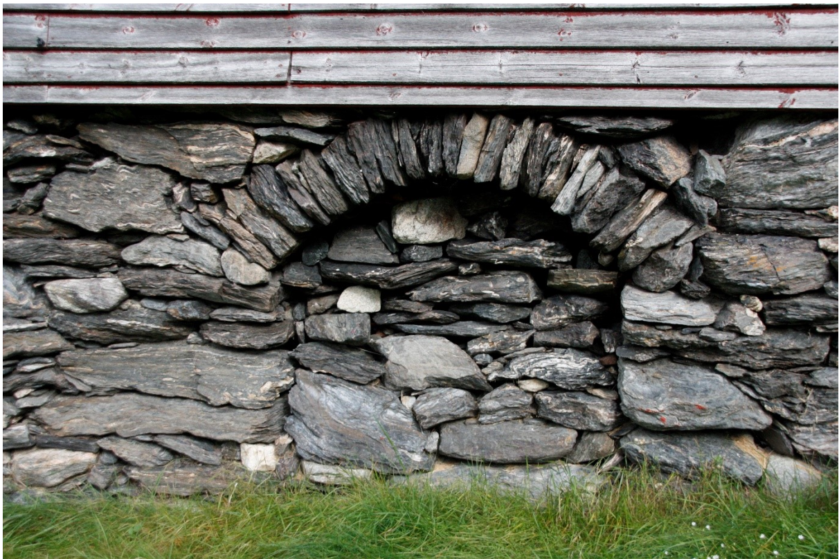
Figur 146. Attmurt kvelva opning i gavlen mot hagen. Foto Arlen Bidne/Vestland fylkeskommune, 2022.
