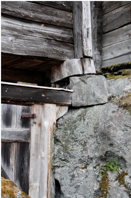
Figur 23. Stabe i front av stabburet mot Linastova. Foto Arlen Bidne/Vestland fylkeskommune, 2022.
