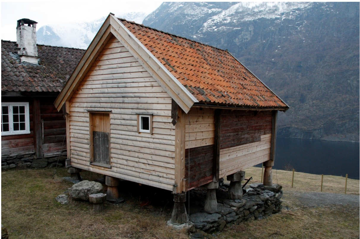
Figur 68. Langsida og gavlveggen mot tungata på oppsida av tunet. Foto Arlen Bidne/Vestland fylkeskommune, 2022.
