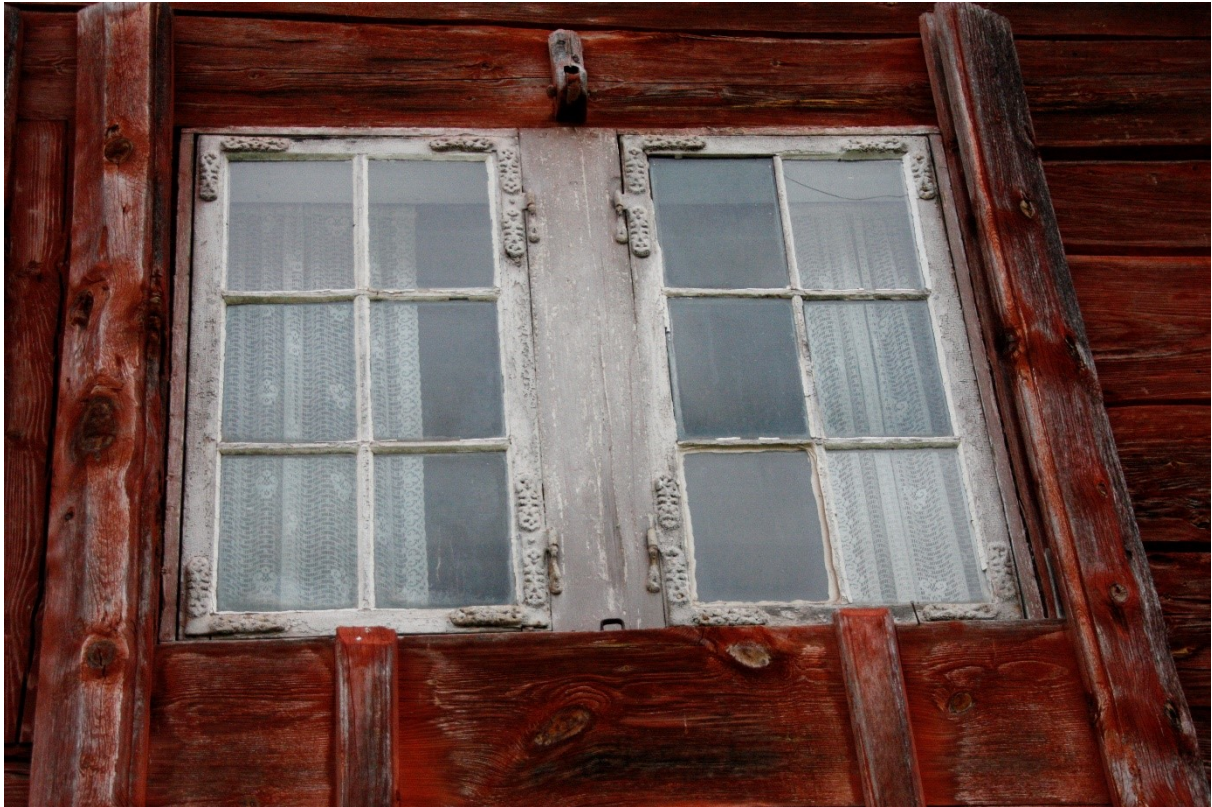
Figur 124. stovevindauga med dekorerte hengsler og beslag. Foto Arlen Bidne/Vestland fylkeskommune, 2022.
