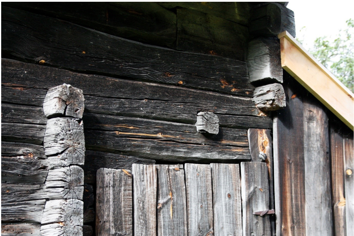
Figur 64. Overgangen mellom stall og skot. Foto Arlen Bidne/Vestland fylkeskommune, 2022.
