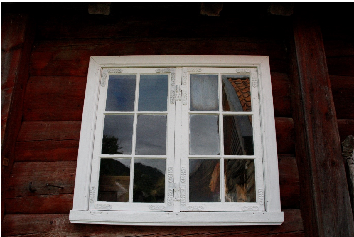
Figur 97. Vindauga i langveggen mot stabburet. Begge foto Arlen Bidne/Vestland fylkeskommune, 2022.
