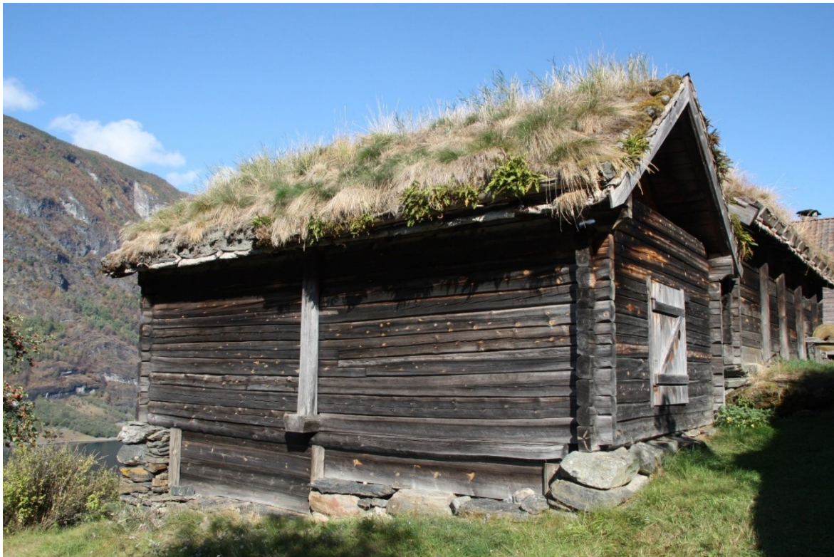
Figur 45. Langsida og gavlen med inngangsdøra. Foto Arlen Bidne/Vestland fylkeskommune, 2021.
