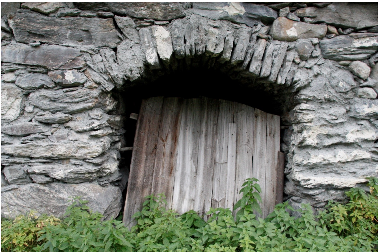
Figur 150. Kvelva døropning i langsida mot fjorden. Foto Arlen Bidne/Vestland fylkeskommune, 2022.
