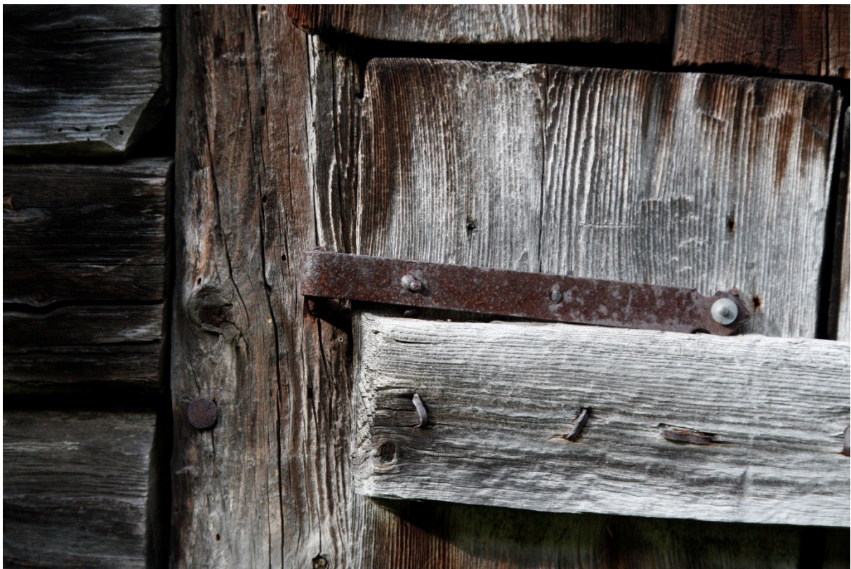
Figur 154. Detalj av hengsle i låvedøra. Foto Arlen Bidne/Vestland fylkeskommune, 2022.
