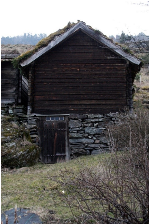
Figur 48. Gavlsida mot fjorden. Vi ser her dei høge murane som gjev plass for ein kjellar under løa. Foto Arlen Bidne/Vestland fylkeskommune, 2022.
