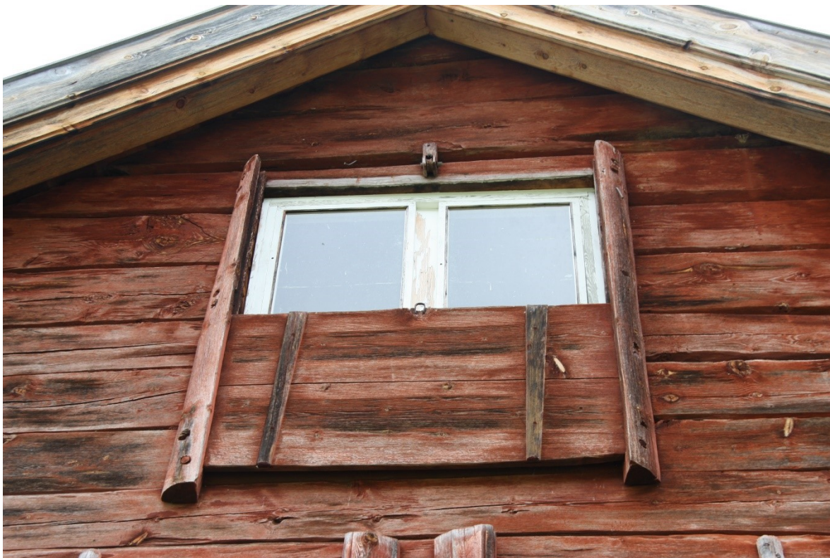
Figur 119. Vindauga med skyvelem øvst i gavlen mot fjorden. Foto Arlen Bidne/Vestland fylkeskommune, 2022.
