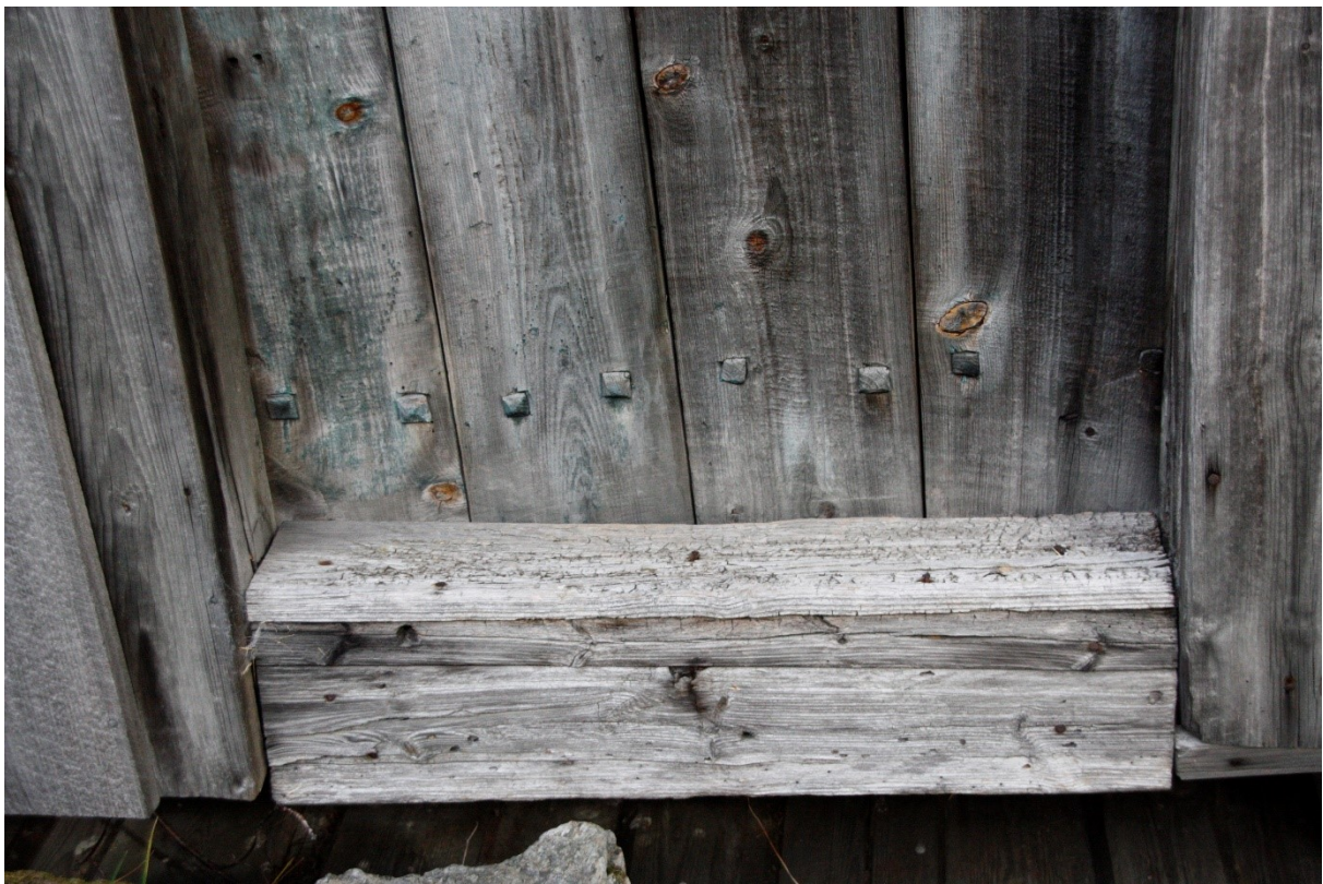
Figur 20. Detalj av dørstokk og trenaglar i inngangsdøra. Foto Arlen Bidne/Vestland fylkeskommune, 2022.
