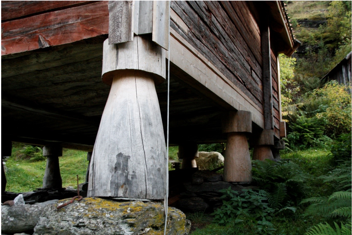
Figur 75. Stabbane på langsida mot Eilertstova. Foto Arlen Bidne/Vestland fylkeskommune, 2022.
