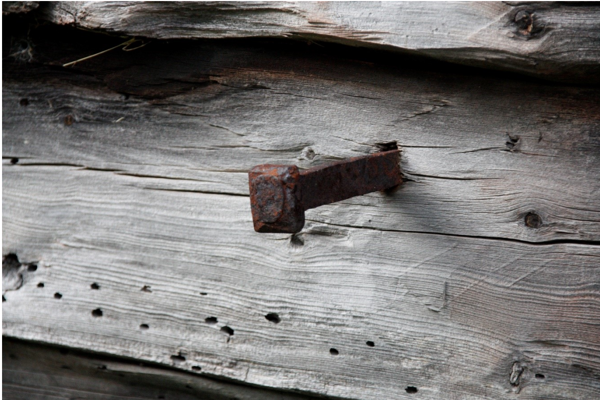
Figur 157. Bolt brukt til å feste oppling. Foto Arlen Bidne/Vestland fylkeskommune, 2022.
