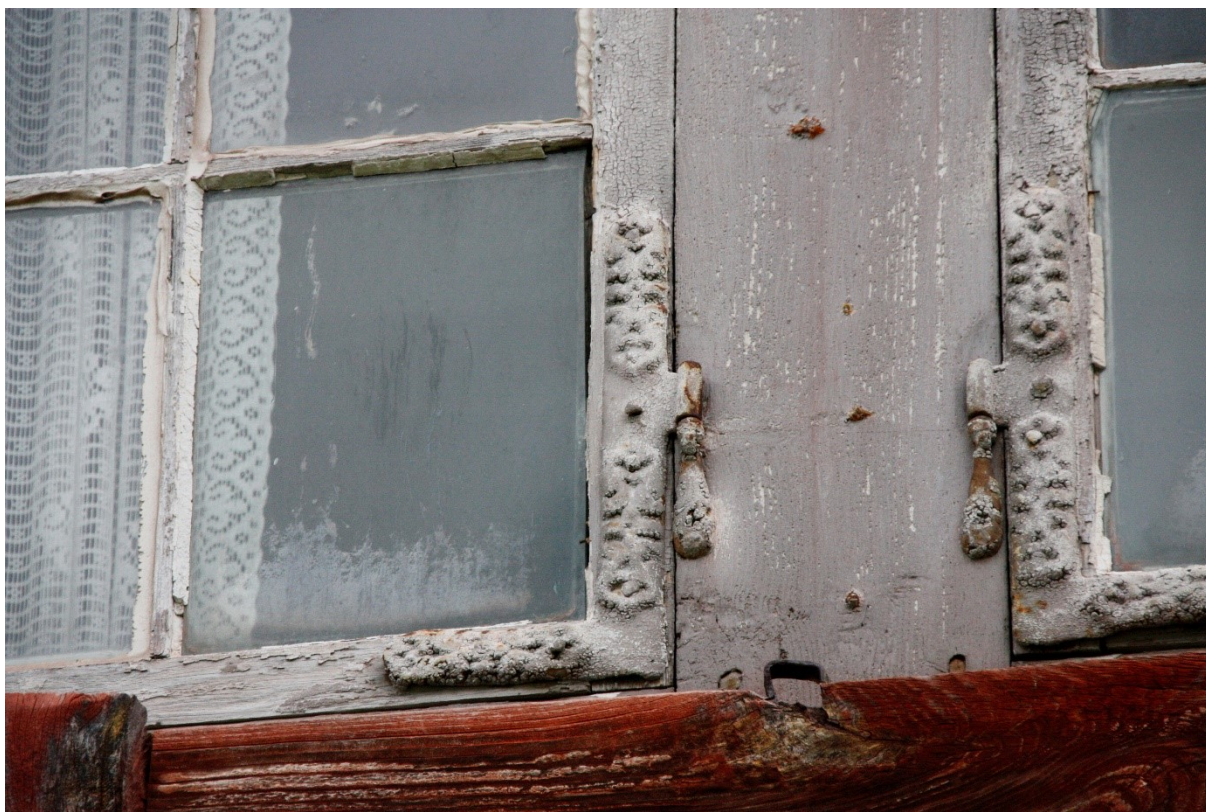
Figur 123. Detalj av dekorerte hengsler. Foto Arlen Bidne/Vestland fylkeskommune, 2022.
