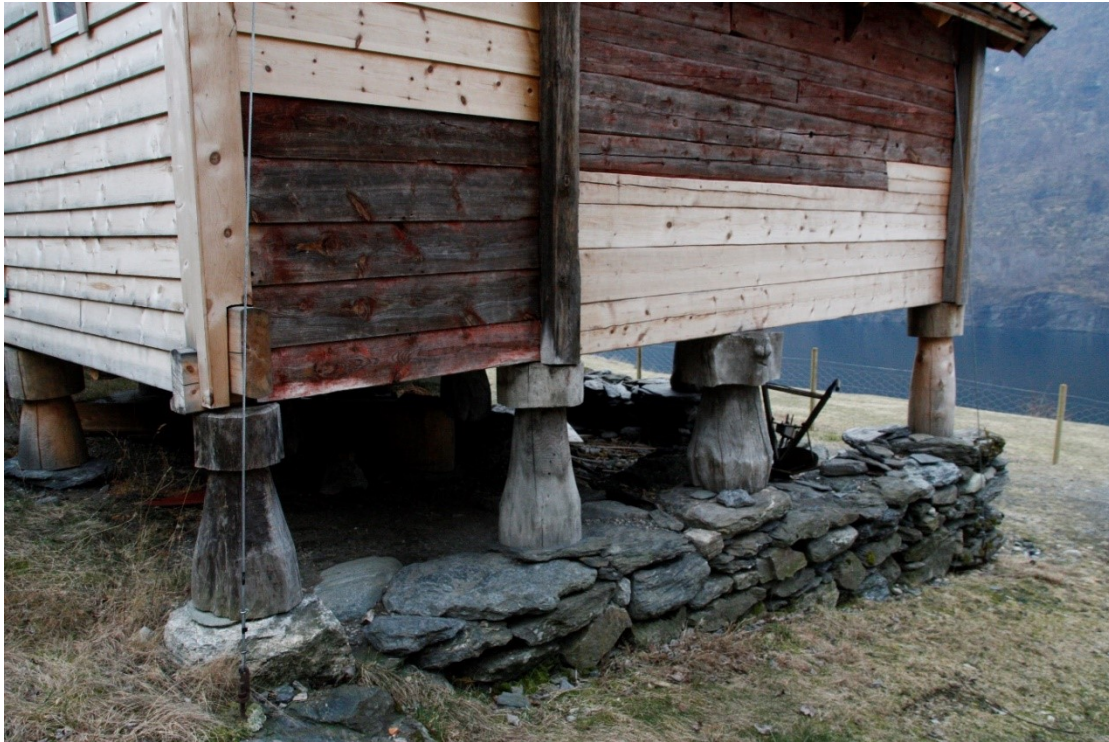
73. Stabbar og mur under langsida. Foto Arlen Bidne/Vestland fylkeskommune, 2022.
