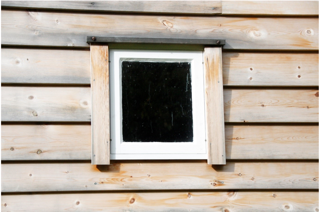
Figur 79. Vindauga i gavlen med inngangsdøra. Foto Arlen Bidne/Vestland fylkeskommune, 2022.
