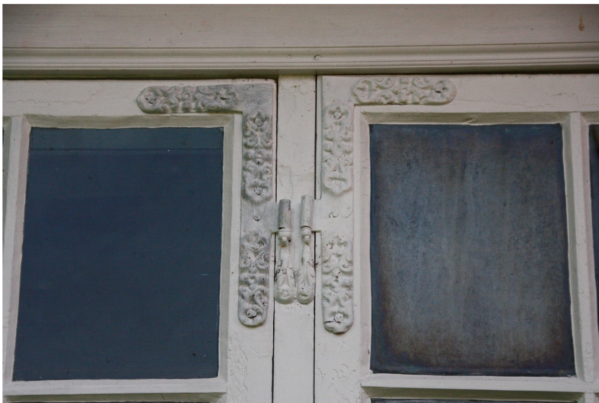
Figur 98. Detalj av hengsler og beslag. Foto Arlen Bidne/Vestland fylkeskommune, 2022.
