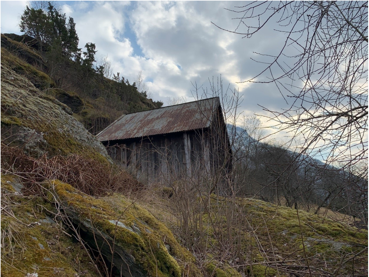
Figur 171. Langveggen inn mot tunet. Foto Arlen Bidne/Vestland fylkeskommune, 2022.
