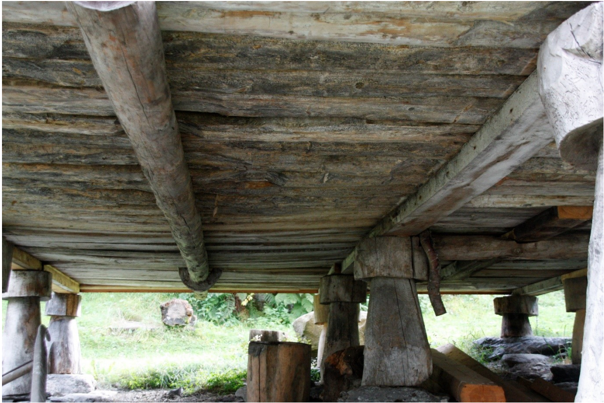
Figur 77. Bjelkelaget under stabburet og stabbane som ber det. Foto Arlen Bidne/Vestland fylkeskommune, 2022.
