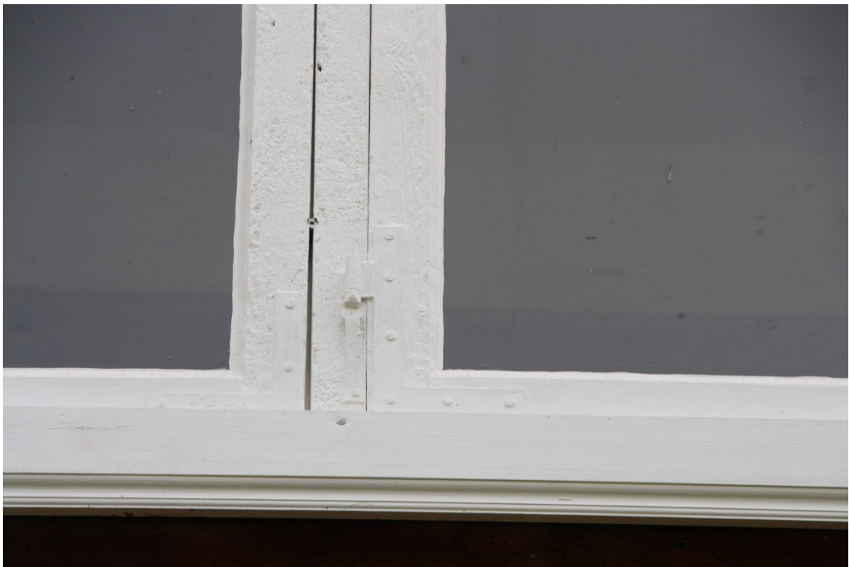
Figur 103. Vindaugsbeslag til vindauga i gavlen mot fjorden. Foto Arlen Bidne/Vestland fylkeskommune, 2022.
