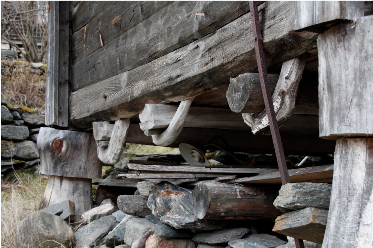
Figur 24. Feste til bjelkelaget. Foto Arlen Bidne/Vestland fylkeskommune, 2022.
