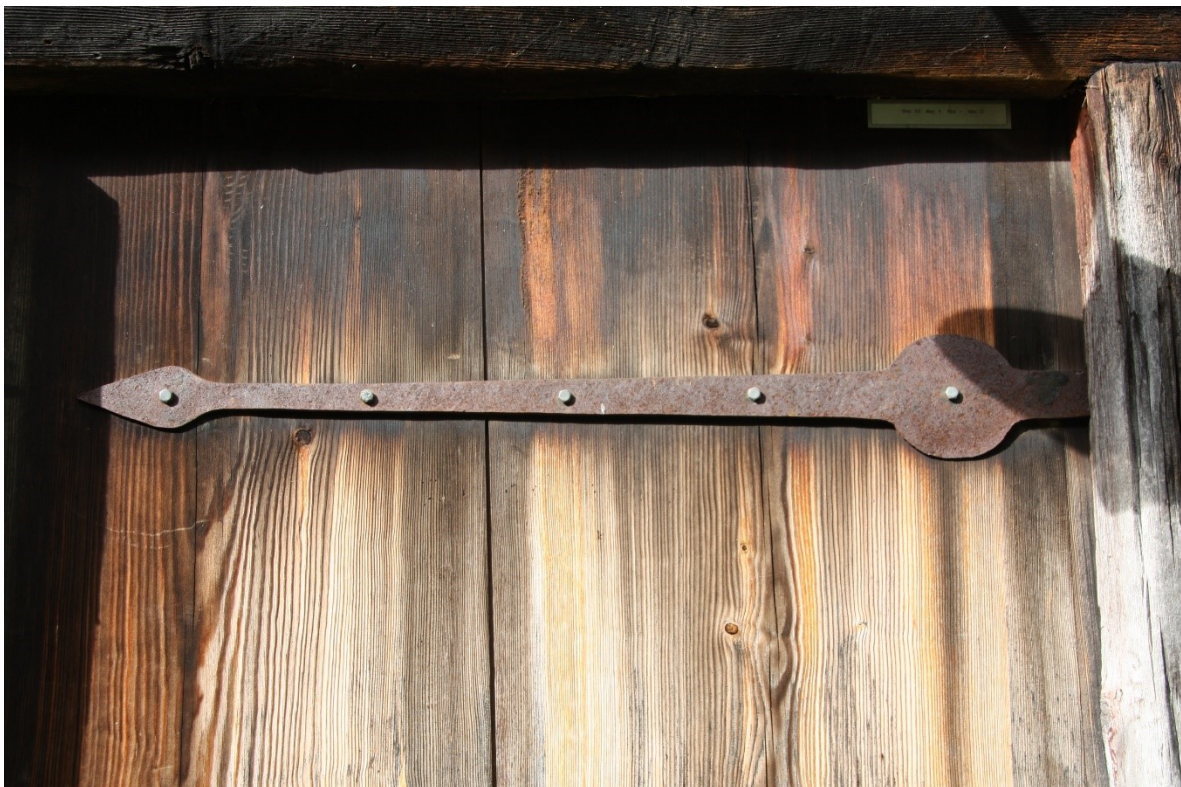
Figur 58. Detalj av dørhengsla. Foto Arlen Bidne/Vestland fylkeskommune, 2022.
