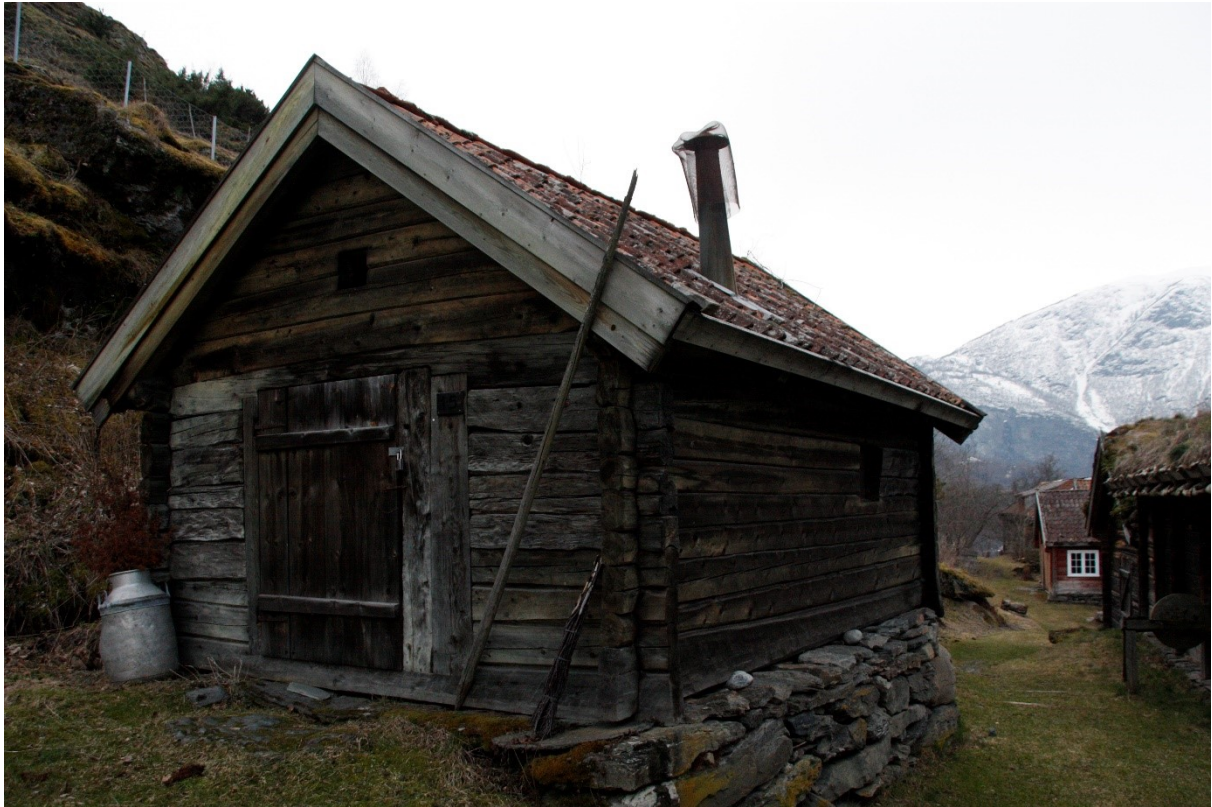
Figur 80. Gavlen med inngangsdøra og langsida mot tunet. Foto Arlen Bidne/Vestland fylkeskommune, 2022.
