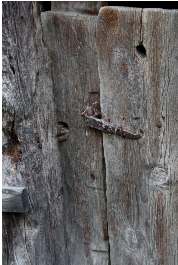
Figur 37 og Figur 38. Kjellardøra. Til venstre detalj av låskroken. Til høyre detalj av hengsle. Foto Arlen Bidne/Vestland fylkeskommune, 2022.
