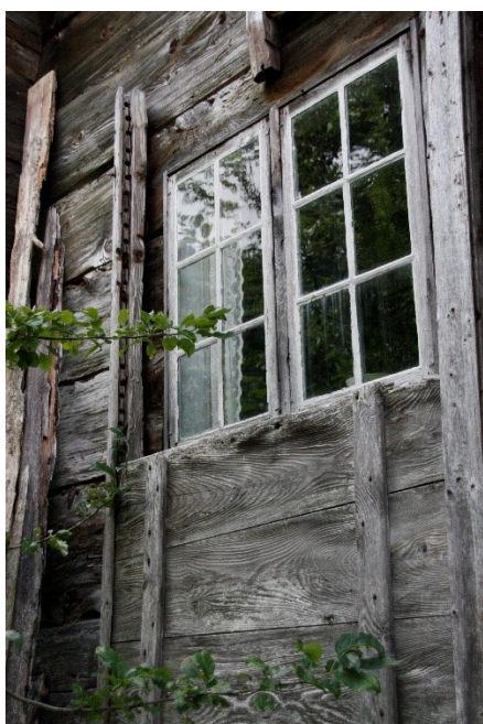
Figur 26 og Figur 27. Vindauga i gavlen sin første etasje. Til venstre ser vi ein av dei bevarte skyvelemmane. Foto Arlen Bidne/Vestland fylkeskommune, 2022.
