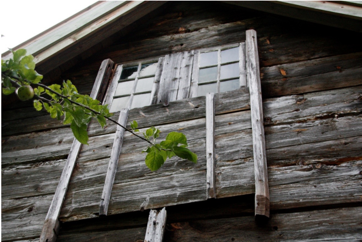
Figur 28. Vindauga i gavlen med skyvelem. Foto Arlen Bidne/Vestland fylkeskommune, 2022.
