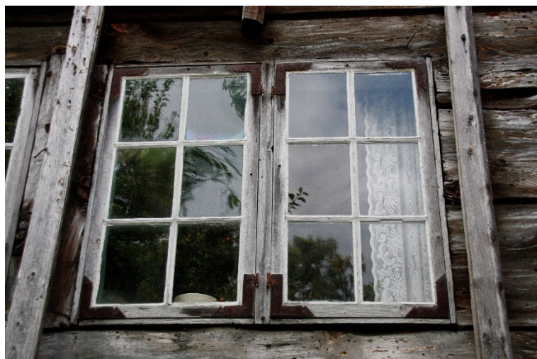
Figur 26 og Figur 27. Vindauga i gavlen sin første etasje. Til venstre ser vi ein av dei bevarte skyvelemmane. Foto Arlen Bidne/Vestland fylkeskommune, 2022.
