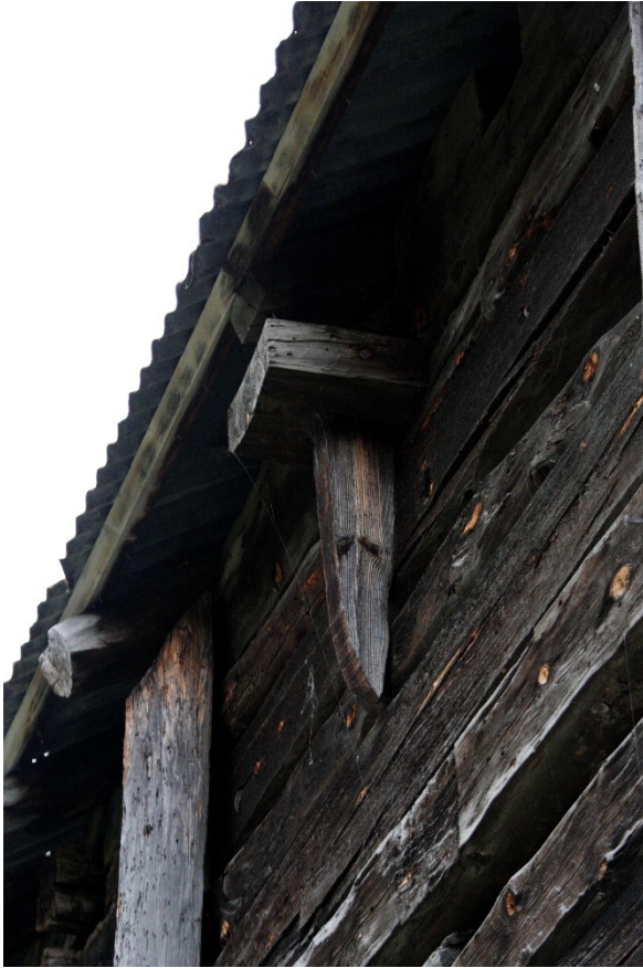
Figur 118 og Figur 119. Til venstre ser vi korleis bjelkelaget er festa med ei "nål". Til høgre ser vi samankoplinga mellom to laftekassar. Foto Arlen Bidne/Vestland fylkeskommune, 2022.
