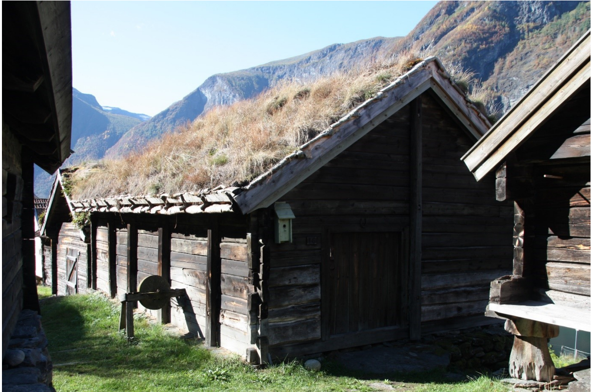
Figur 88. Gavlveggen med inngangsdøra mot stabburet, langveggen langs tungata på oppsida av tunet. Foto Arlen Bidne/Vestland fylkeskommune, 2021.
