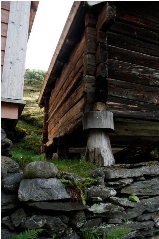
og Figur 70. Stabbane i framkant av stabburet. Foto Arlen Bidne/Vestland fylkeskommune, 2022.
