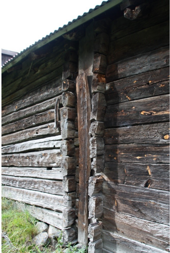
Figur 118 og Figur 119. Til venstre ser vi korleis bjelkelaget er festa med ei "nål". Til høgre ser vi samankoplinga mellom to laftekassar. Foto Arlen Bidne/Vestland fylkeskommune, 2022.
