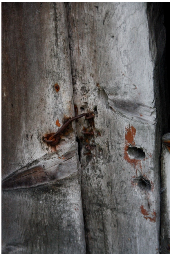
Figur 37 og Figur 38. Kjellardøra. Til venstre detalj av låskroken. Til høyre detalj av hengsle. Foto Arlen Bidne/Vestland fylkeskommune, 2022.
