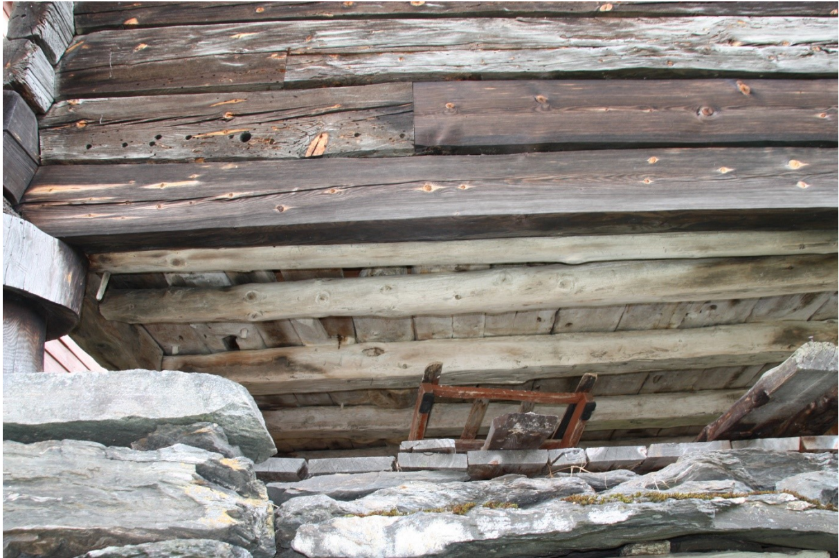
Figur 75. Bjelkelaget under stabburet. Foto Arlen Bidne/Vestland fylkeskommune, 2022.
