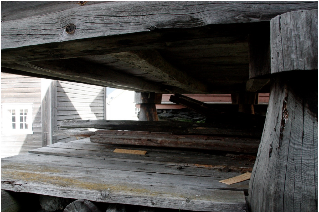
Figur 74. Detalj av tretaket over kjellaren. Foto Arlen Bidne/Vestland fylkeskommune, 2022.
