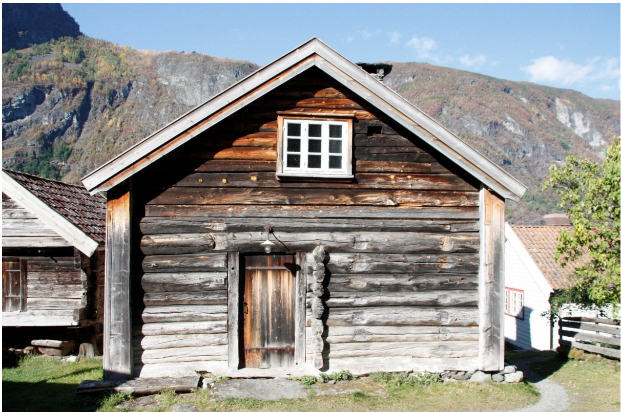
Figur 41. Gavlveggen med inngangsdøra. Dette er einaste veggen i stova som ikkje er kledd med panel. Tømmeret i loftsetasjen er av ein annan karakter enn i første etasje. Foto Arlen Bidne/Vestland fylkeskommune, 2021.
