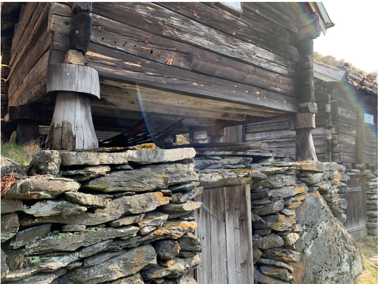
Figur 68. Stabbane som stabburet står på. Foto Arlen Bidne/Vestland fylkeskommune, 2022.
