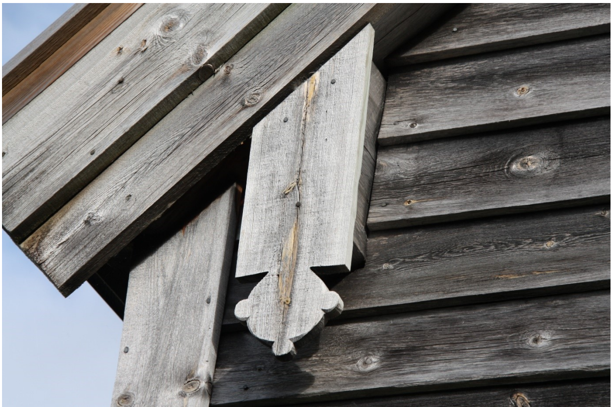
Figur 32. Detalj av hengebrett i gavlen ved inngangsdøra. Foto Arlen Bidne/Vestland fylkeskommune, 2022.
