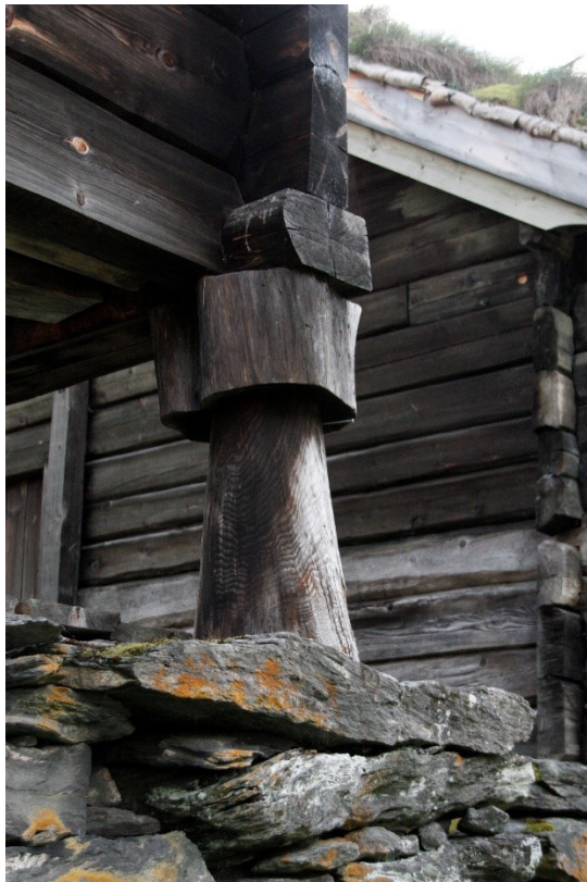
og Figur 70. Stabbane i framkant av stabburet. Foto Arlen Bidne/Vestland fylkeskommune, 2022.
