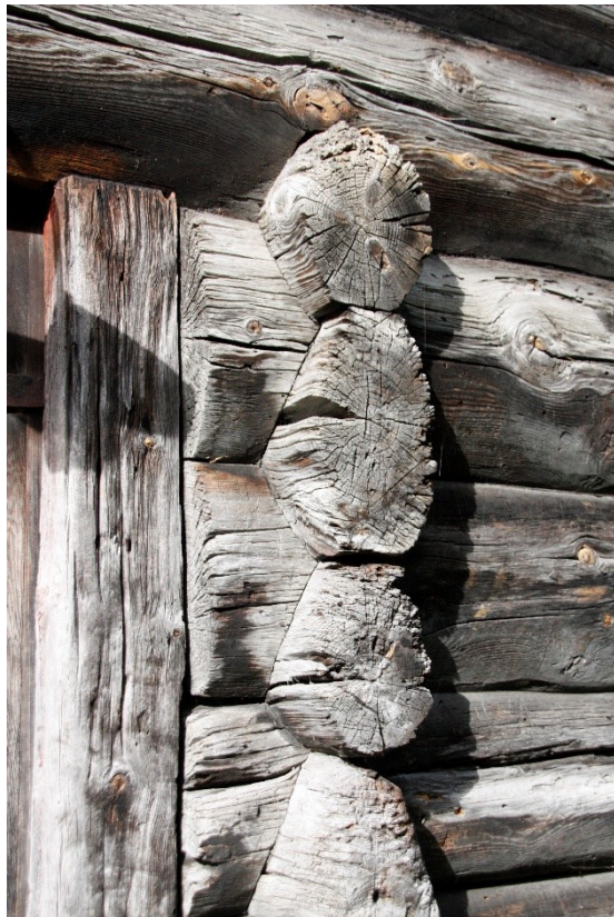
Figur 54 og Figur 55. Til venstre vindauga til kammerset. Til høyre detalj av lafteknutane ved inngangsdøra. Foto Arlen Bidne/Vestland fylkeskommune, 2022.
