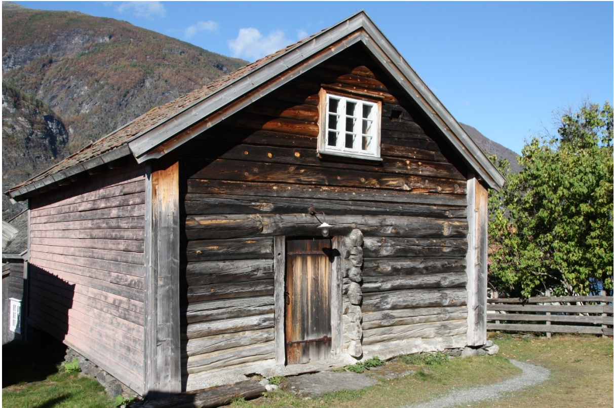
Figur 40. Gavlveggen med inngangsdøra. Langveggen mot stabburet er utan vindauga. Foto Arlen Bidne/Vestland fylkeskommune, 2021.
