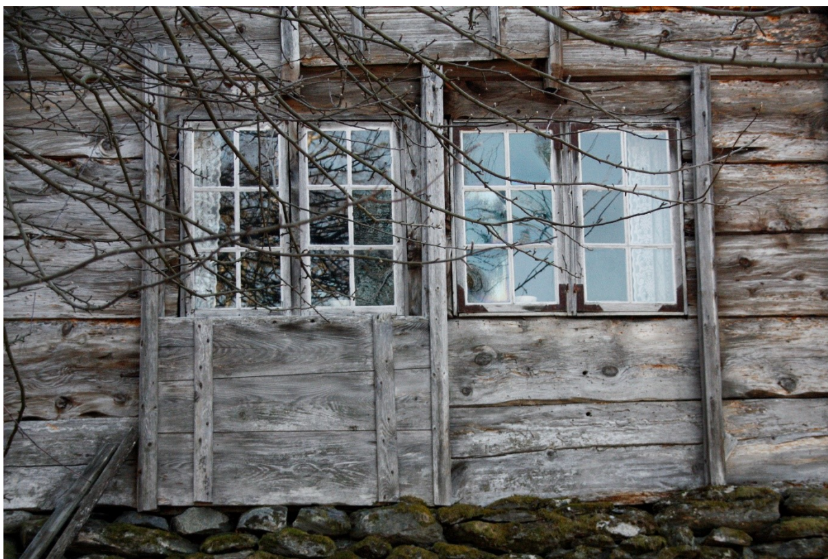
Figur 25. Detalj av vindauga i gavlen mot Vetlastova i Andersgarden. Den eine av skyvelemmane framfor vindauga er framleis bevart. på det andre vindauga er lemme vekte men stolpane med spor til lemme er framleis bevart på begge vindauga. Foto Arlen Bidne/Vestland fylkeskommune.
