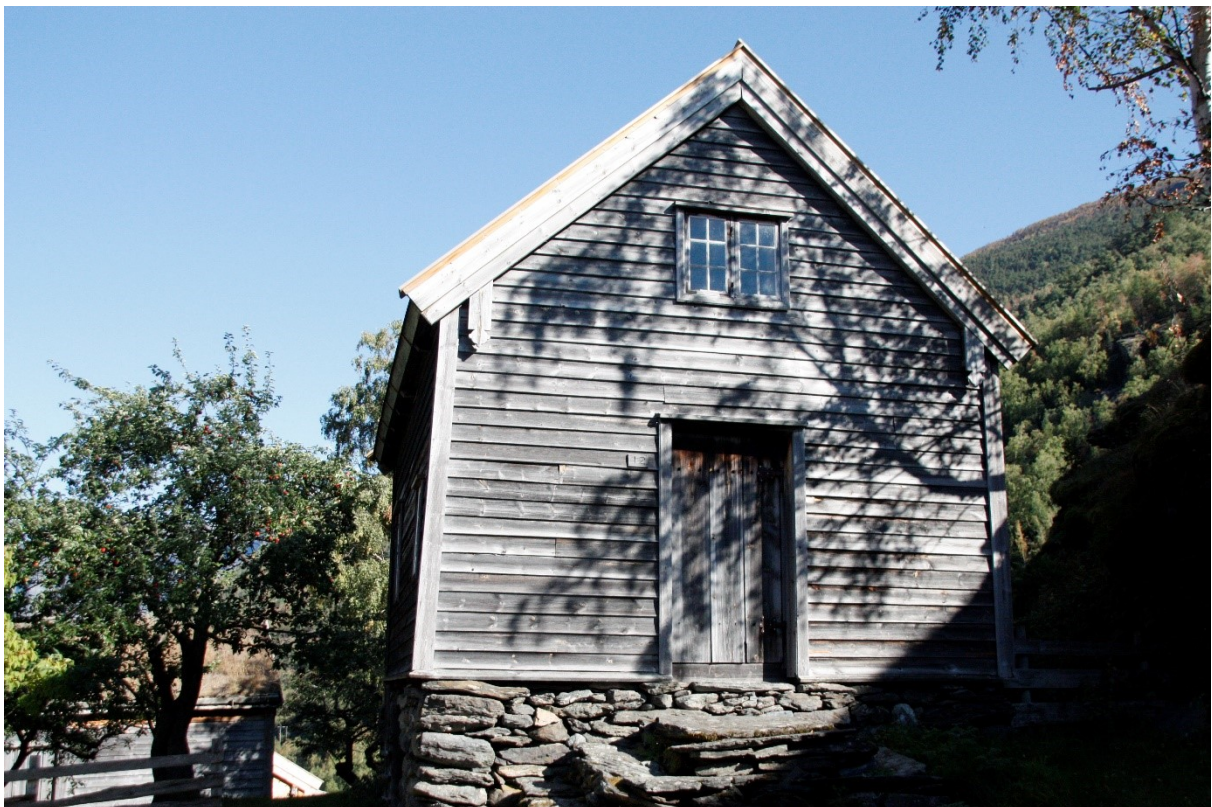
Figur 16. Gavlveggen med inngangsdøra. Foto Arlen Bidne/Vestland fylkeskommune, 2021.
