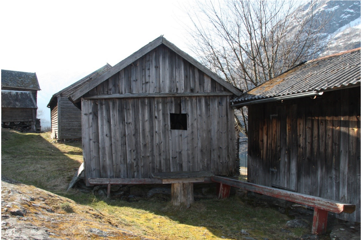
Figur 37. Gavlside med inngangsdøra til eldhuset. Foto Arlen Bidne/Vestland fylkeskommune, 2022.
