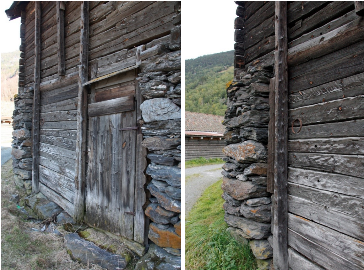
Figur 77. Til venstre dør inn til fjøs i kjellaren, samt lafta vegg i kjellaretasjen. Til høyre detalj av overgang mellom tømmer og mur. Foto Arlen Bidne/Vestland fylkeskommune, 2022.
