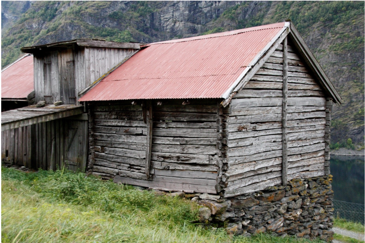
Figur 69. Langsida med låvebrua og gavlen mot løa i Andersgarden. Foto Arlen Bidne/Vestland fylkeskommune, 2022.
