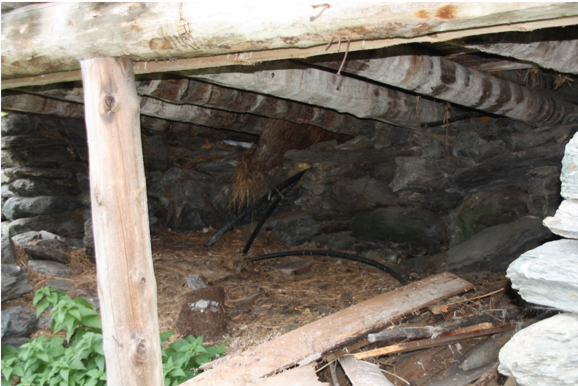
Figur 36. Bjelkelaget under sauefjøs. Foto Arlen Bidne/Vestland fylkeskommune, 2022.
