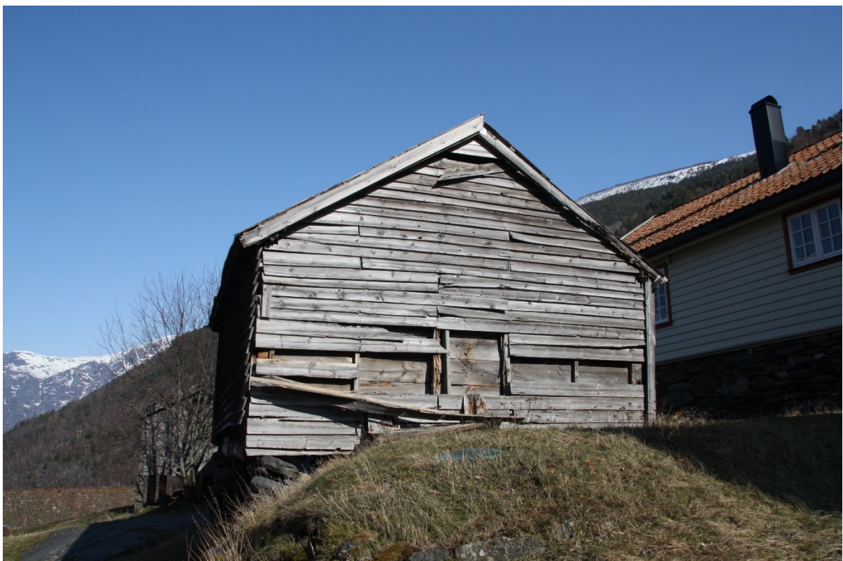
Figur 29. Gavlsida mot Guttormgarden. Foto Arlen Bidne/Vestland fylkeskommune, 2022.
