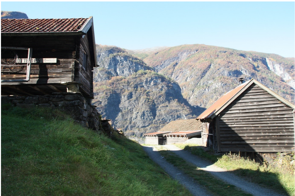
Figur 49. Frå køyrevegen inn i tunet, med tre av bygningane til Andersgarde. Frå venstre ser vi stabburet, løa og fjøs. Foto Arlen Bidne/Vestland fylkeskommune, 2021.
