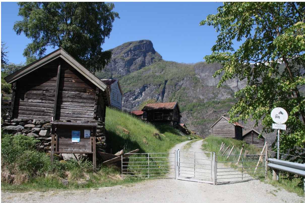
Figur 55. Tunet sett frå parkeringsplassen. Bygningane til Andersgarden er dei første ein møter. Foto Arlen Bidne/Vestland fylkeskommune, 2021.
