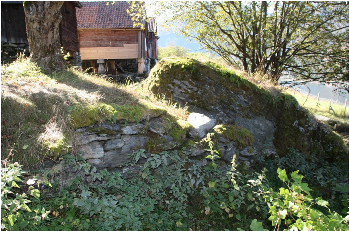
Figur 123. Oppmura parti i nederkant av hagen mellom stabeløa og stallen i Thomasgarden. Foto Arlen Bidne/Vestland fylkeskommune, 2021.
