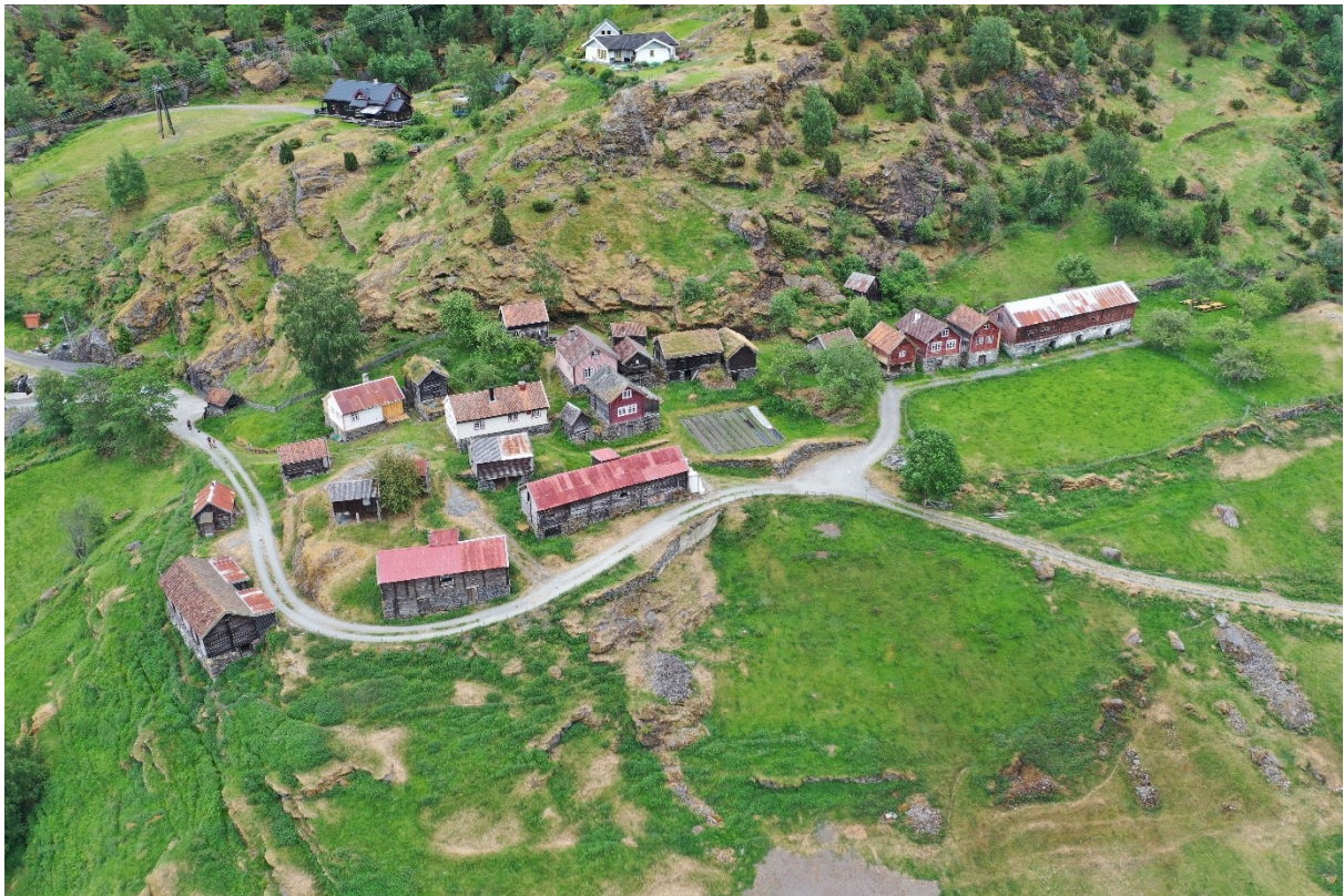
Figur 8. Otternestunet sett mot aust. Biletet viser alle dei attverande bygningane i tunet. Foto Glenn Heine Orkelbog/Vestland fylkeskommune 2021.
