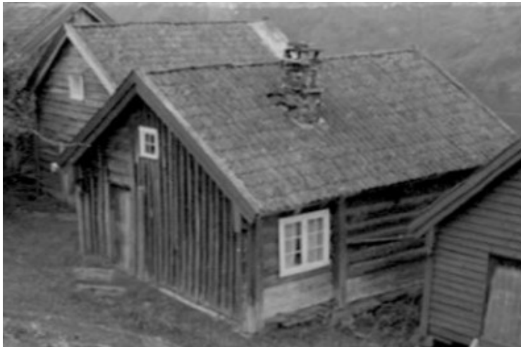
Figur 264. Gavlveggen med inngangsdøra
