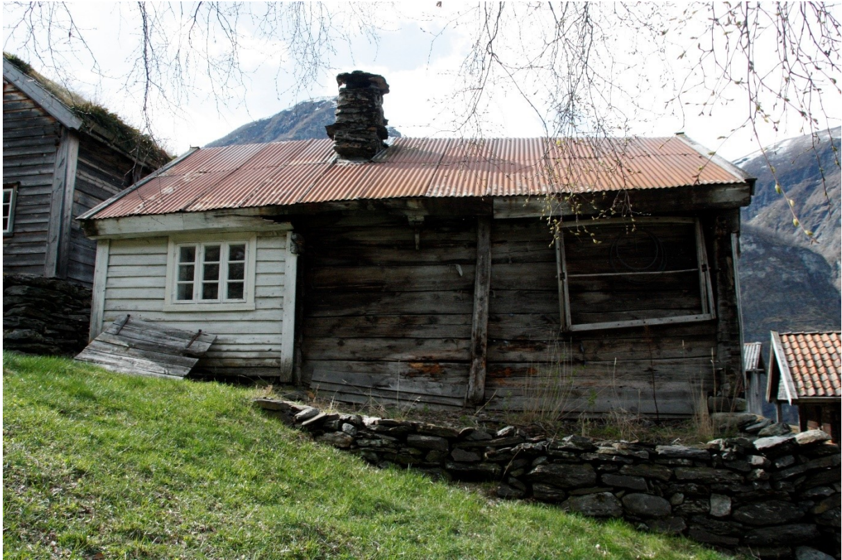
Figur 330. Håkonstova, langveggen mot parkeringsplassen. På dette tidspunktet var tilbygget på langsida vekke og kun grunnmuren stod att. Foto Arlen Bidne/Sogn og Fjordane fylkeskommune, 2017.
