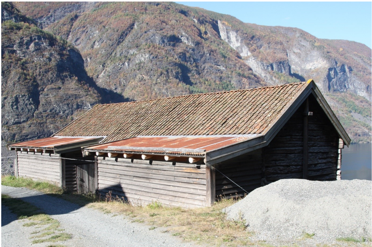
Figur 93. Løa med kyr- og geitefjøs. Vi ser her tilbygga langs langveggen mot bilvegen. Foto Arlen Bidne/VLFK, 2021.
