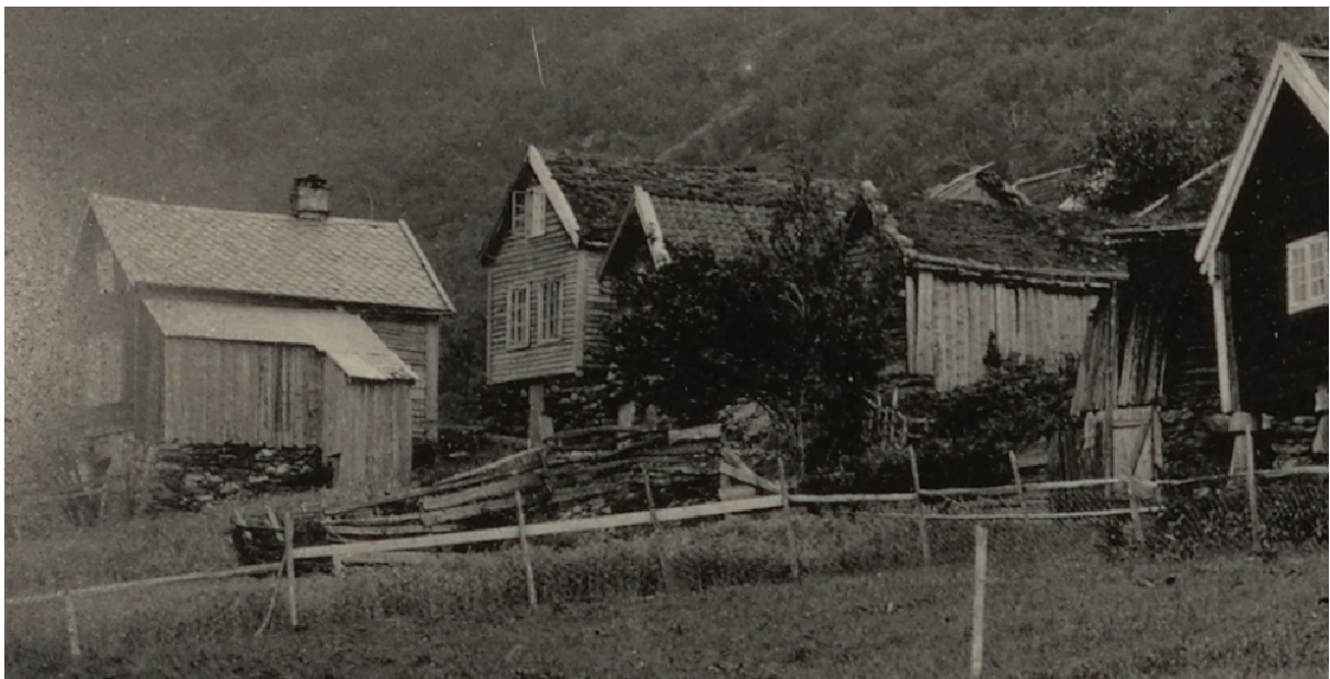
Figur 137. Til venstre Linastova der vi ser at tilbygget på langveggen har fått ei forlenging . Til høgre i biletet ser vi langveggen til stabbeløa som på denne tida var kledd med ståande panel og hadde saltak. Utsnitt av foto av A. Bugge, 1926, Riksantikvaren.
