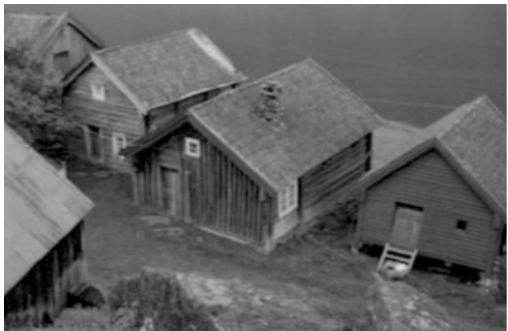
Figur 266. Eilertstova sett frå hagen bak tunet. Lengst til venstre ser
