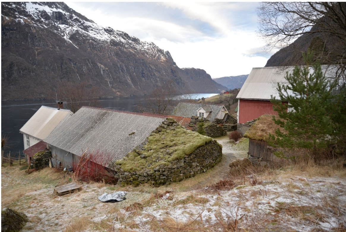
Figur 24. Oppsida av tunet. Vi ser her mellom annan nokon av dei store steinmurane i gavlane på husa. Murane var sett opp for å beskytte husa mot fonnvind. Foto Stig Nordrumshaugen/SFF 2017.
