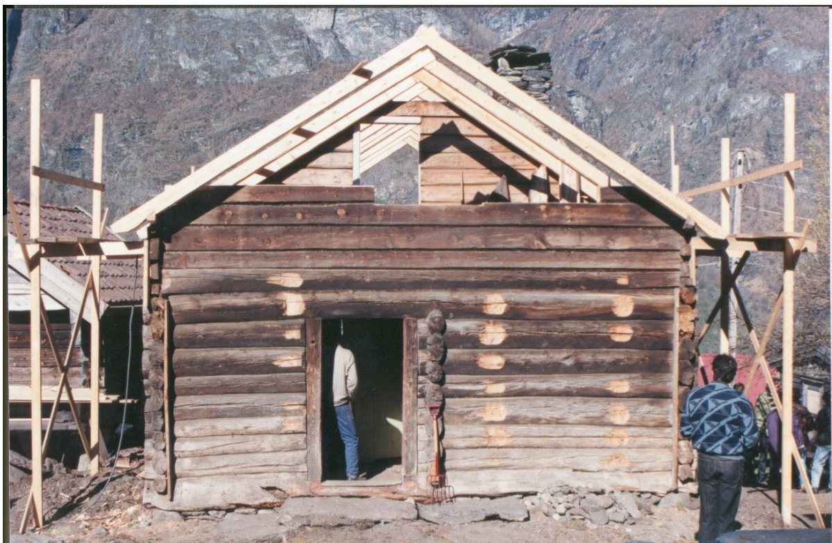
Figur 292. Istandsetjing av Gjertrudstova, nye sperrer er montert og delar av gavlen er demontert. Foto frå Aurland kommune.
