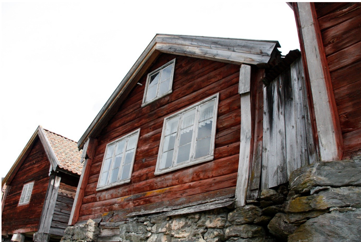
Figur 371. Eilertstova, gavlfasade mot fjorden. Biletet viser også endeveggen i mellombygget mellom Eilertstova og kårstova. Foto Arlen Bidne/Sogn og Fjordane fylkeskommune, 21017.
