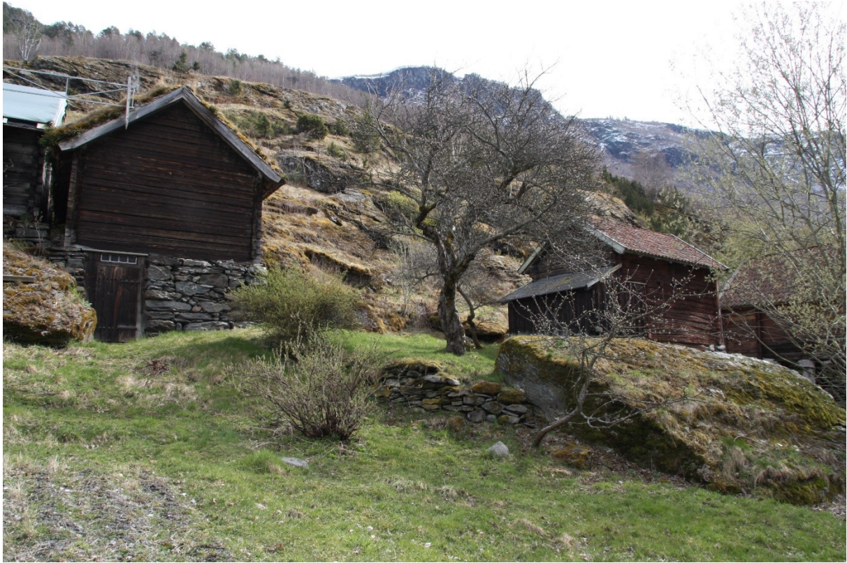
Figur 355. Til venstre er Stabbeløa og til høyre ser vi stallen. mellom disse bygningane ligg hagen med gamle frukttr e og b erbusker. Vi ser ogs a litt av murane som er bygd opp i hagen. Foto Arlen Bidne/Sogn og Fjordane fylkeskommune, 2017.
