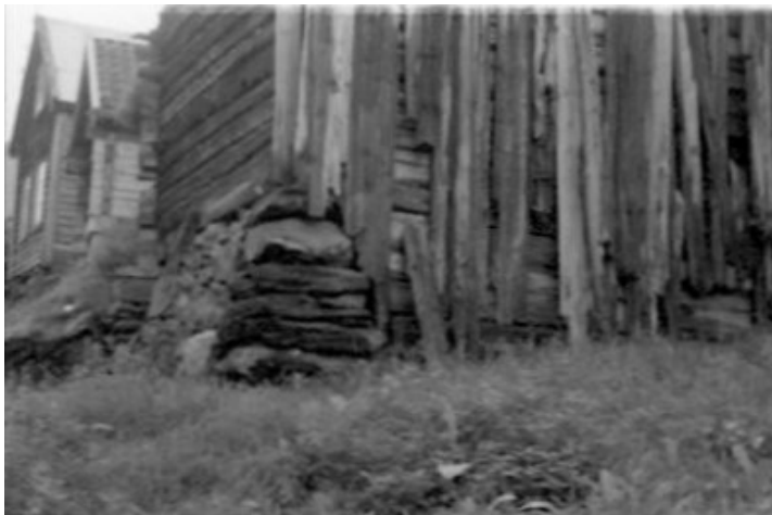
252. Detalj av kledning på langsida.
