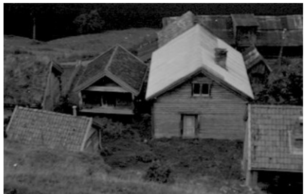
Figur 214 og Figur 215. Gavlveggen på Gjertrudstova. Vi ser her at den då hadde ei fyllingsdør med to fyllingar.
