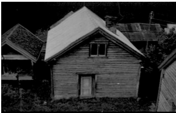
Figur 214 og Figur 215. Gavlveggen på Gjertrudstova. Vi ser her at den då hadde ei fyllingsdør med to fyllingar.
