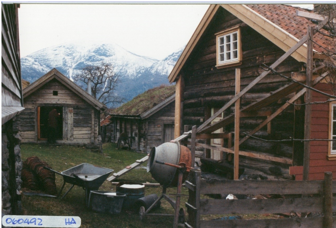
Figur 295. Istandsetjinga av Gjertrudstova nærmar seg ferdigstilling. Til venstre er eldhuset i Guttormgarden ferdig restaurert. Foto Aurland kommune.
