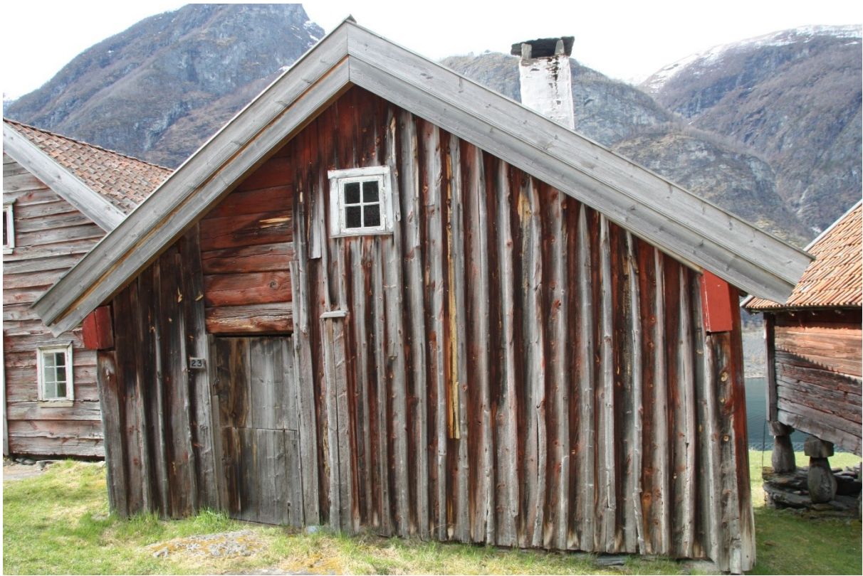
Figur 363. Eilertstova, gavlveggen med inngangsdøra. Foto Arlen Bidne/Sogn og Fjordane fylkeskommune, 2017.
