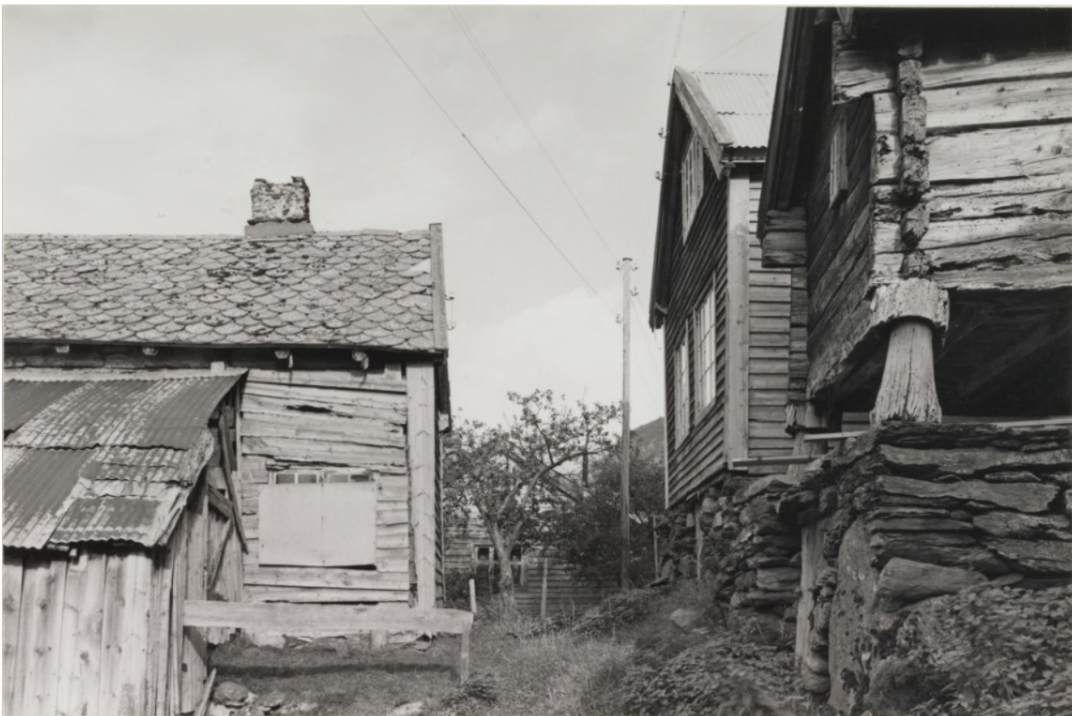
Figur 80. Linastova til venstre, bak i midten er Oddastova med den tidlegare frukthagen i gavlen. til høgre er Gjertrudstova og stabburet i Guttormgarden. Foto K. Skjeggestad, 1974. Riksantikvaren.
