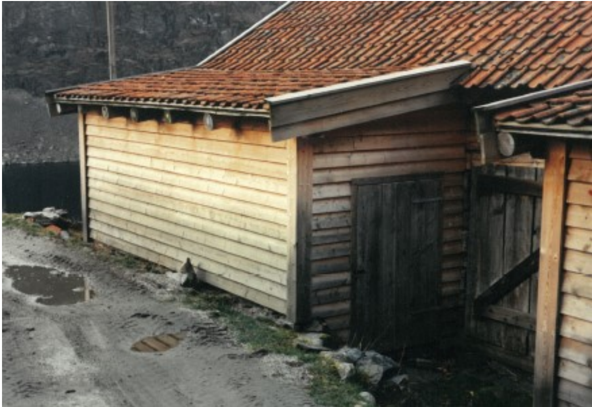
Figur 285. Løa med nye tilbygg. Foto Aurland kommune.
