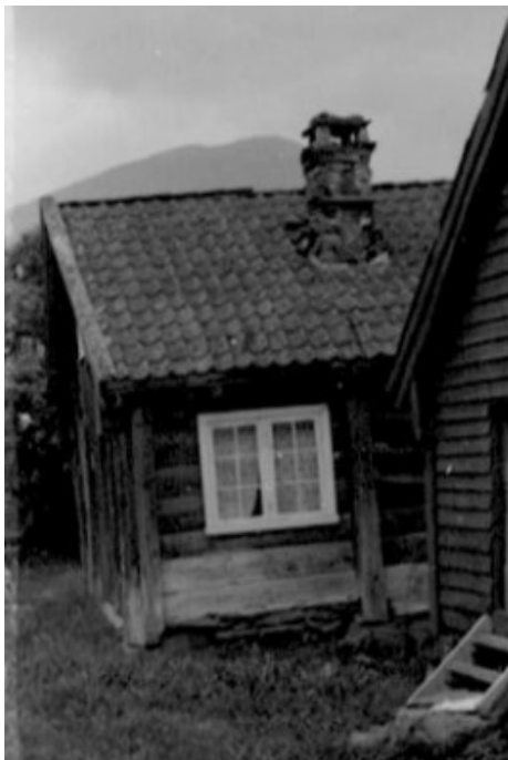
Figur 265. Langveggen mot stabburet. vi litt av stabburet.
