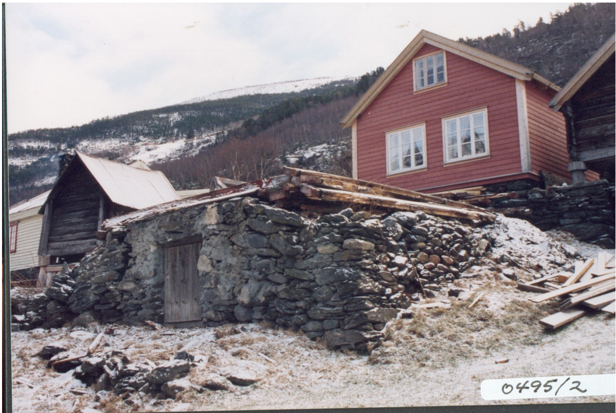
Figur 307. Grunnmuren til Linastova etter at stova vart demontert. Foto Aurland kommune.
