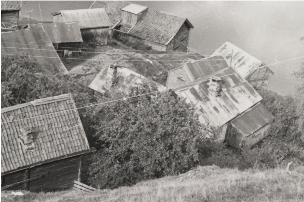
Figur 147. I 1974 var stabburet i Andersgarden kledd med liggande panel i gavlen med inngangsdøra og det hadde byljeblekk tak. Utsnitt av foto av K. Skjeggstad, Riksantikvaren.
