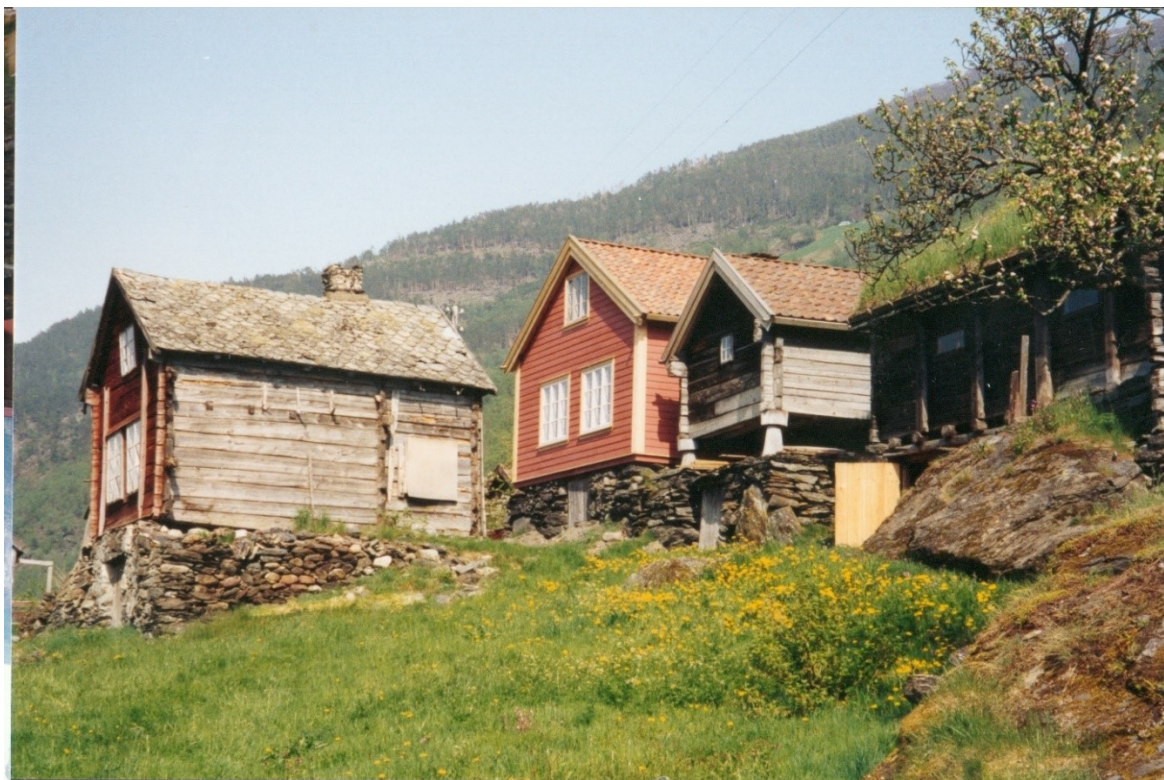
Figur 304. Linastova før istandsetjing, skotet og utedoen langs langveggen er riven. Vi ser her at Gjertrudstova og stabburet ved sida av den er ferdig restaurert. På stabburet ser vi tydeleg kva material som er ny og kva som er gammalt. Foto frå Aurland kommune.
