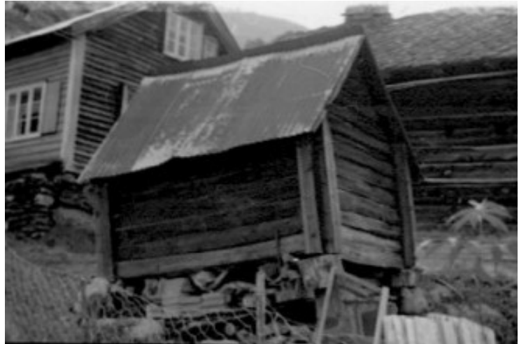
Figur 241. Langsida og gavlveggen mot fjorden.
