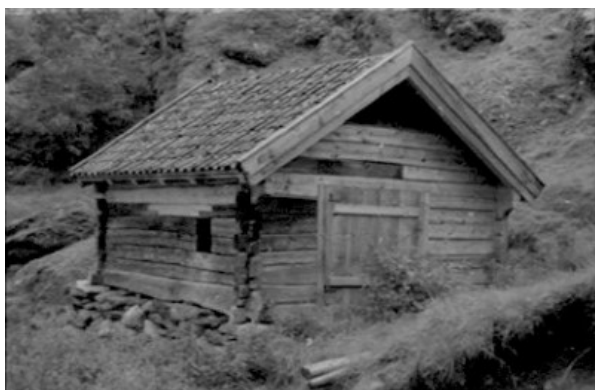
Figur 164. Langside og gavl med inngangsdør.
