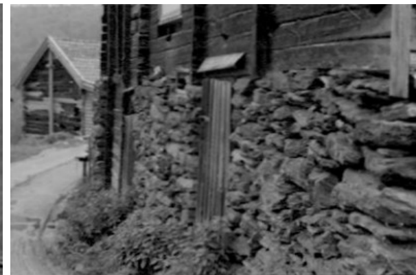
Figur 207. Grunnmuren på framsida av løa.
