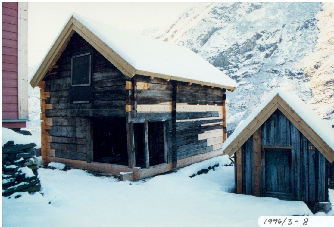
315. Tømmerkassa til Linastova er lafta opp att. Biletet viser tydeleg grad av utskifting av material. Foto Aurland kommune, 1996.
