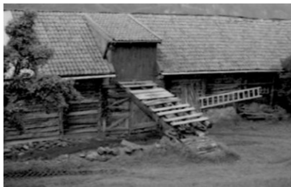
Figur 276. Langveggen med låvebru.
