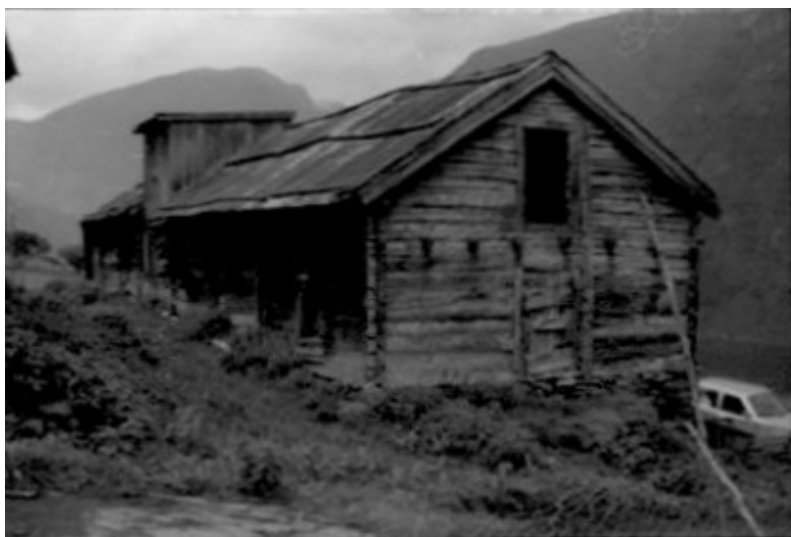
Figur 233. Langsida mot stovehuset
