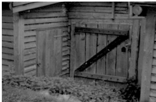
Figur 177. Detalj av dør inn til løe mellom tilbygga.
