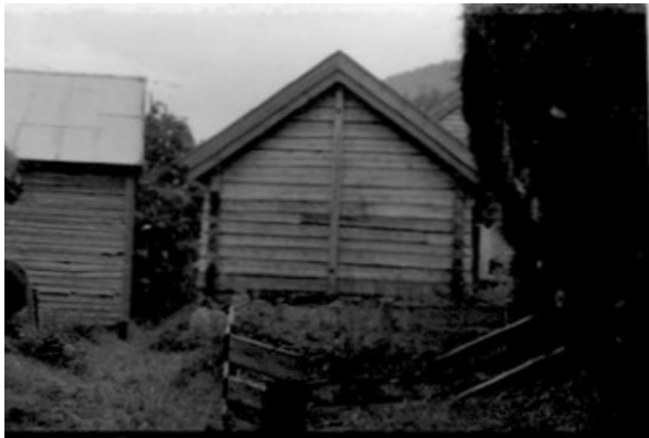
Figur 224. Havlveggen mot Thomasgarden. inngangsdøra.
