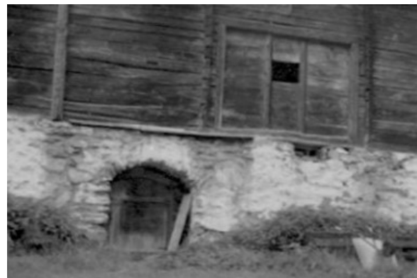
Figur 278. Detalj av dør inn til kjellaren.
