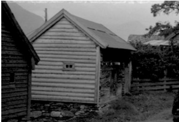
Figur 255. Gavlsida og langsida mot tunet.
