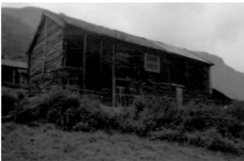
Figur 203. Langsida ut mot fjorden.
