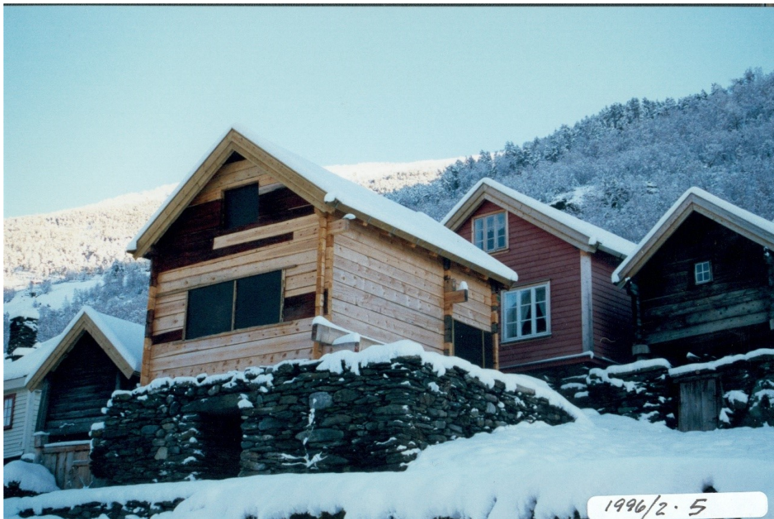
313. Tømmerkonstruksjonen ferdig remontert og det er lagt nytt tak. Foto Aurland kommune, 1996.
