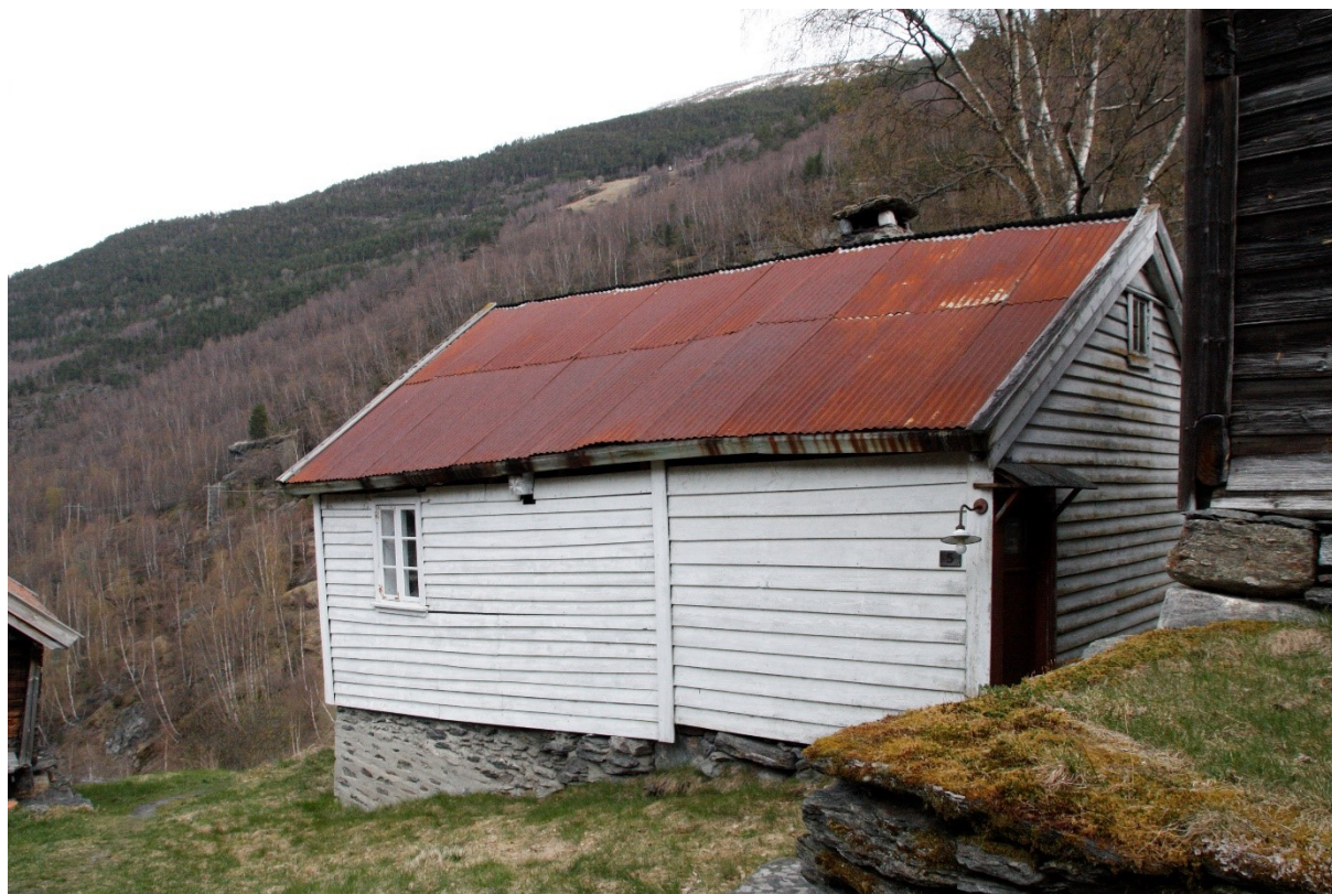
Figur 329. Håkonstova før istandsetjinga starta. Vi ser her at på dette tidspunktet hadde stova inngangsdør i gavlen mot Vetlastova. Foto Arlen Bidne/Sogn og Fjordane fylkeskommune, 2017.
