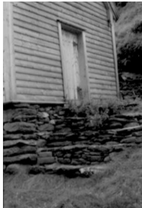
Figur 212. Inngangsdøra med utvendig trapp.
