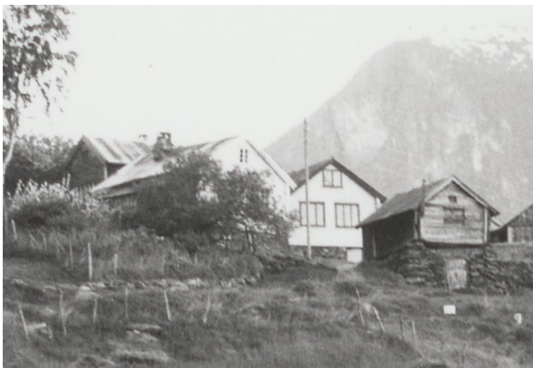
Figur 149. Andersgarden i 1972, vi ser her at gavlveggen til Håkonstova er kvitmåla og er sannsynlegvis kledd med liggande kledning. Detalj av foto frå Fylkeskonservatoren i Sogn og Fjordane, Riksantikvaren.
