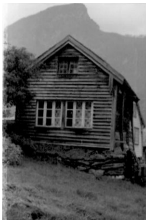
Figur 189. Gavlveggen inn mot hagen.
