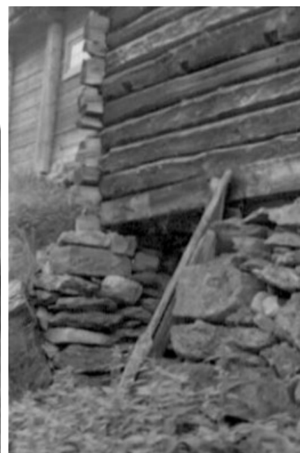
Figur 253. Detalj av tømmerveggen i kortsida mot fjorden.
