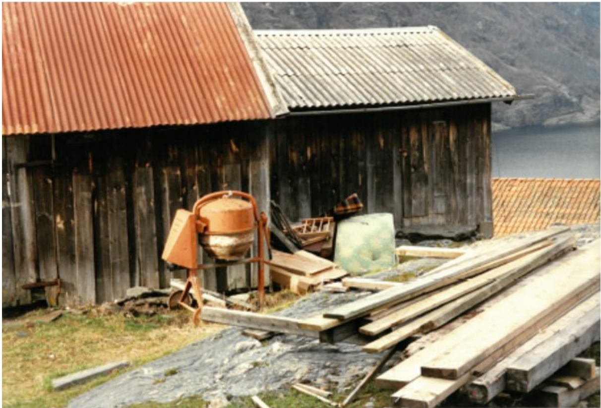
Figur 300. Eldhuset og stabburet i Guttormgarden. Foto Aurland kommune.
