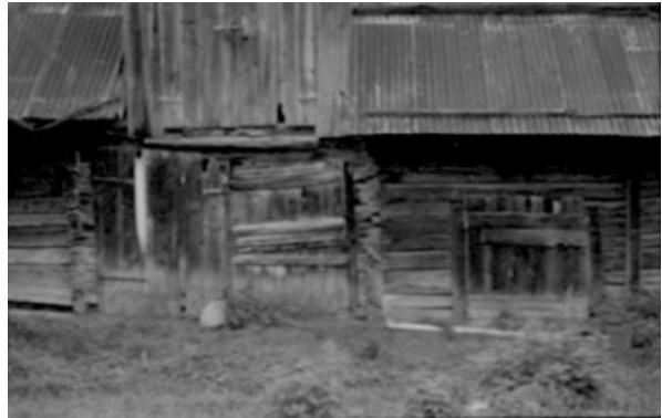
Figur 237. Detalj av dører på langsida mot stovehuset.
