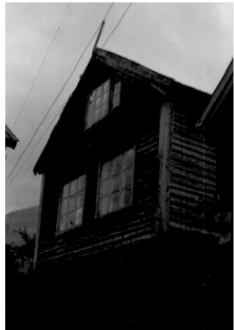
Figur 217. Gavlveggen mot fjorden.
