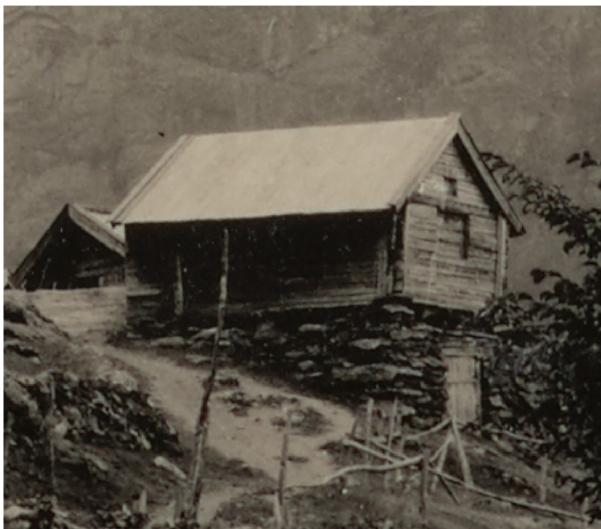
Figur 132. Stabburet i Andersgarden 1926. I bakgrunnen er del av gavlen til fjøset som tidlegare stod her. Utsnitt av foto av A. Bugge, Riksantikvaren.
