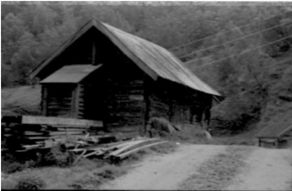
Figur 171. Gavlsida med tilbygg til utedo.
