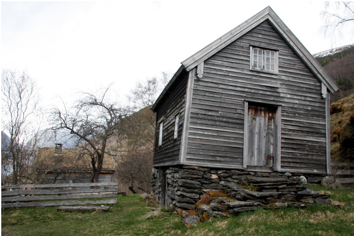
Figur 346. Nystova, gavlen med inngangsdøra. Til venstre litt av hagen og bak hagen ligg Vetlastova i Andersgarden. Foto Arlen Bidne/Sogn og Fjordane fylkeskommune, 2017.
