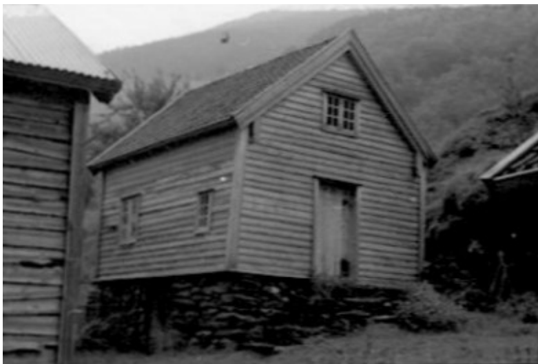
Figur 208. Langsida mot hagen og gavlsida med inngangsdøra.
