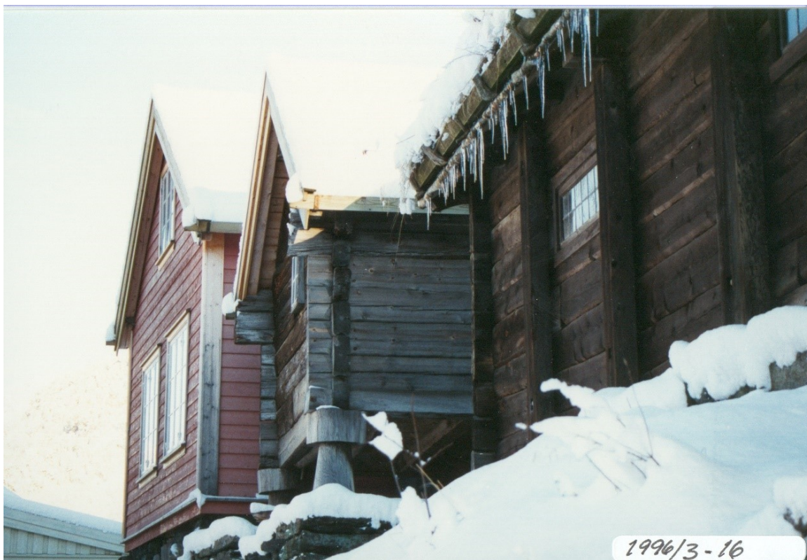
Figur 297. Gjertrudstova ferdig istandsett. På stabburet ved sida av stova er taket sett i stand og kopien av fjøsen er ferdig. Foto frå Aurland kommune, 1996.
