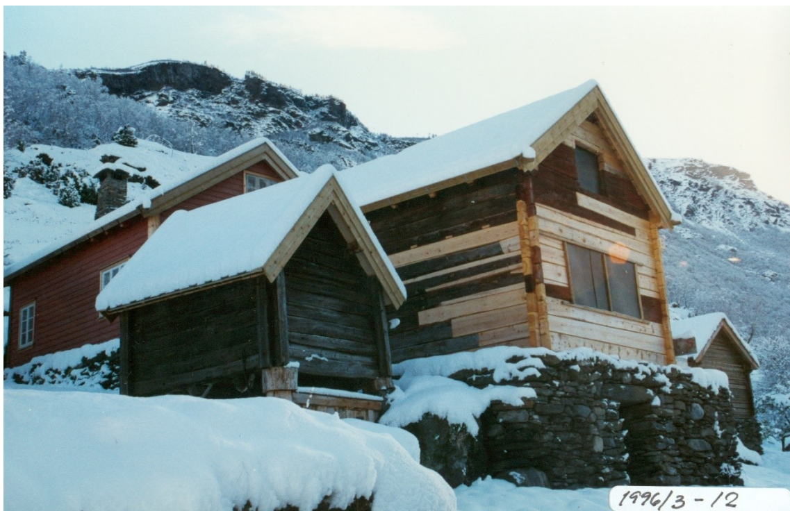
314. Tømmerkonstruksjonen er ferdig remontert og stova har fått nytt tak. Til venstre i biletet ser vi noko av takreparasjonane og ein ny stabbe på stabburet. Foto Aurland kommune, 1996.
