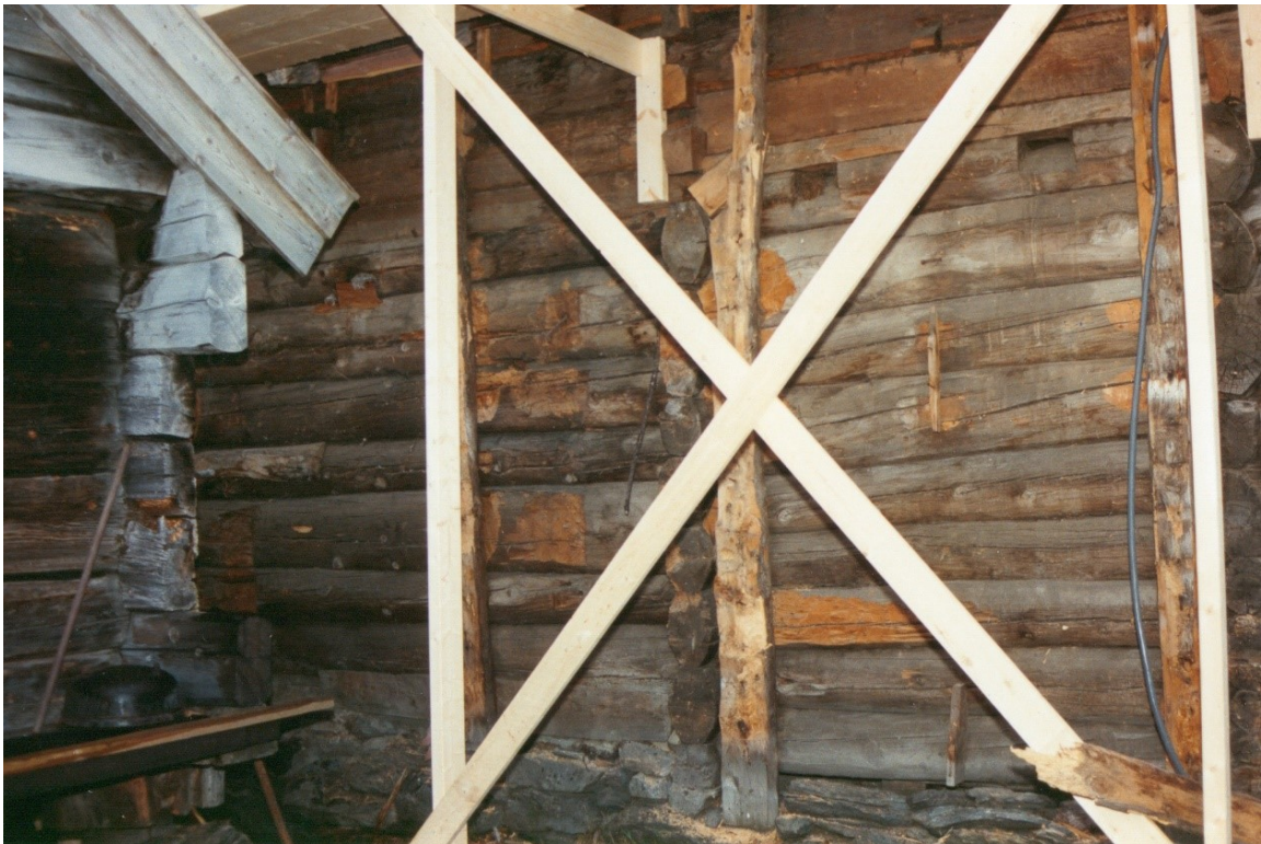
Figur 294. Langsida mot stabburet under restaurering. Foto Aurland kommune.
