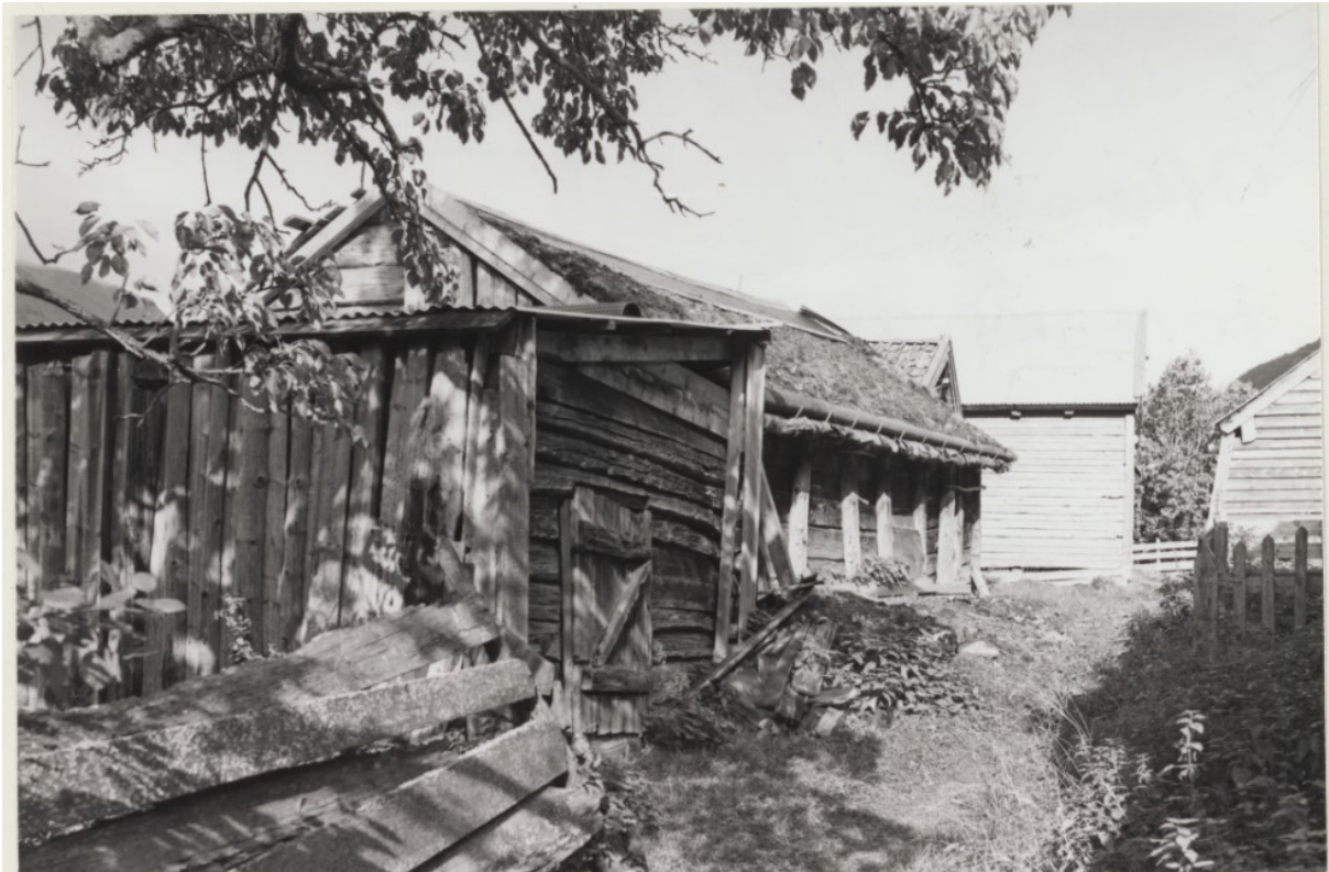
Figur 79. Tunet sett frå tungagta ved Thomasgarden mot Guttormgarden. Foto K- Skjeggestad, 1974, Riksantikvaren.
