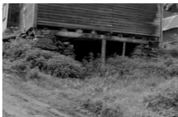
Figur 202. Grunnmuren og stokkar som held bjelkelaget
