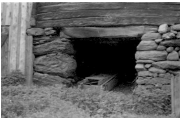
Figur 257. Detalj av det opne rommet under stallen.
