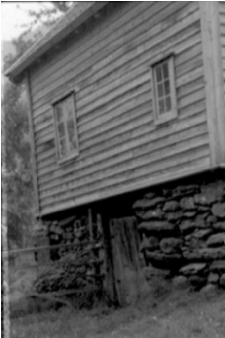
Figur 209. Langsida mot hagen.
