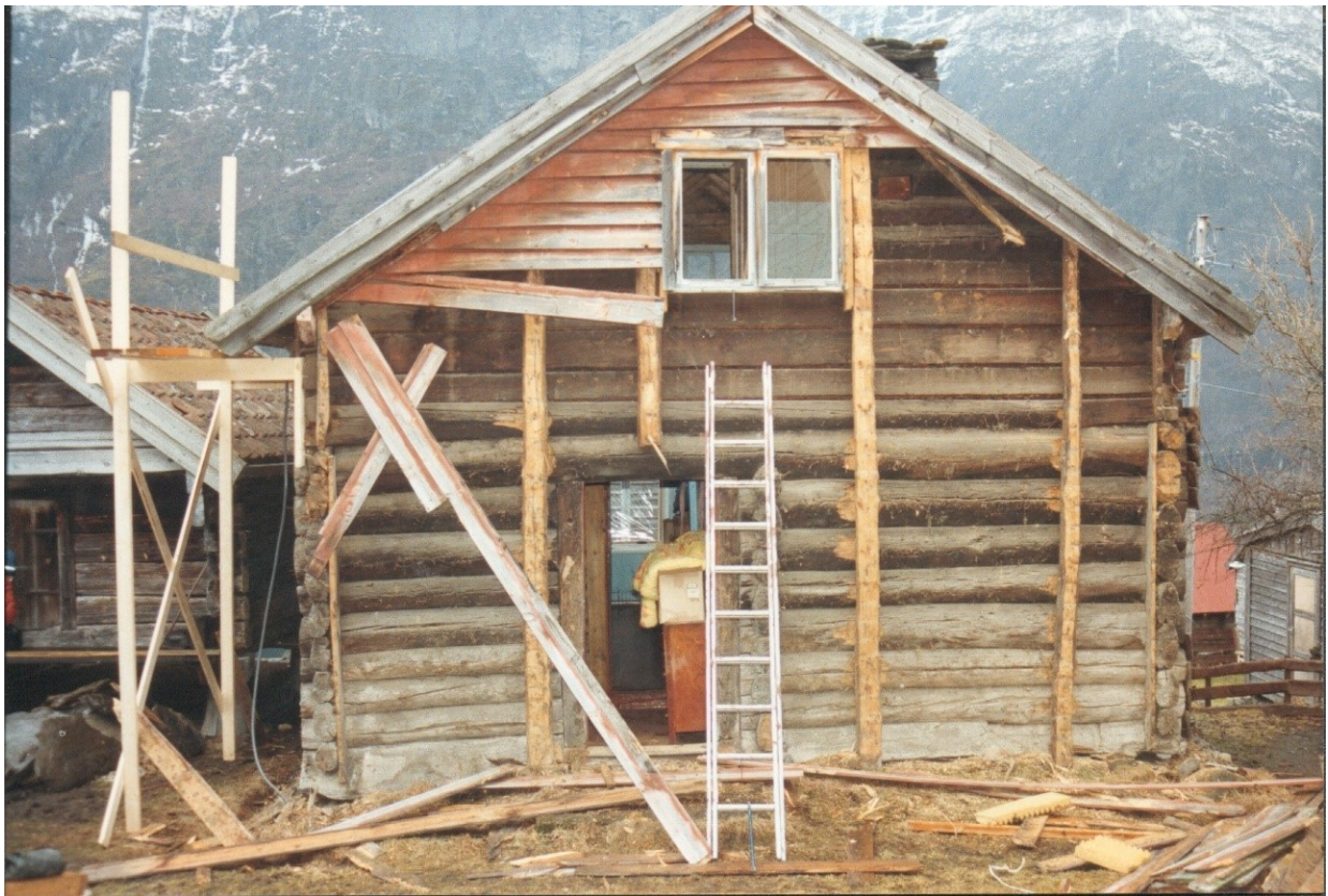
Figur 291. Istandsetjinga av Gjertrudstova er starta opp, delar av kledningen er riven. Foto frå Aurland kommune.
