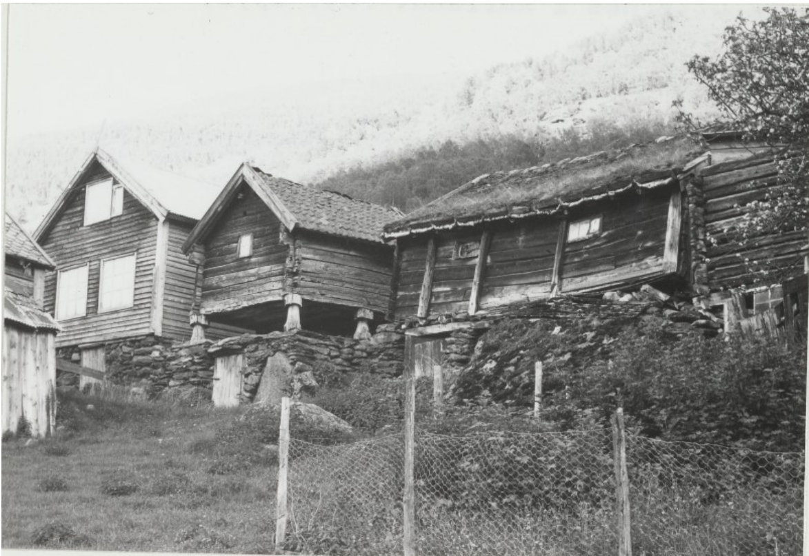
Figur 78. Tre av husa i Guttormsgarden, frå venstre Gjertrudstova, stabburet og fjøs. Foto frå Fylkeskonservatoren, 1972, Riksantikvaren.
