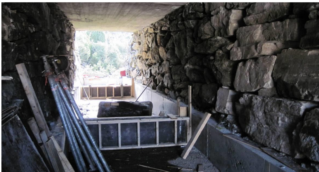
Figur 5. Bildet fra bygging av ny veikulvert ved en bekk på Sotra, Hordaland våren 2010. Her støpes det tverrvegger for å lette oppvandringen for fisk.
