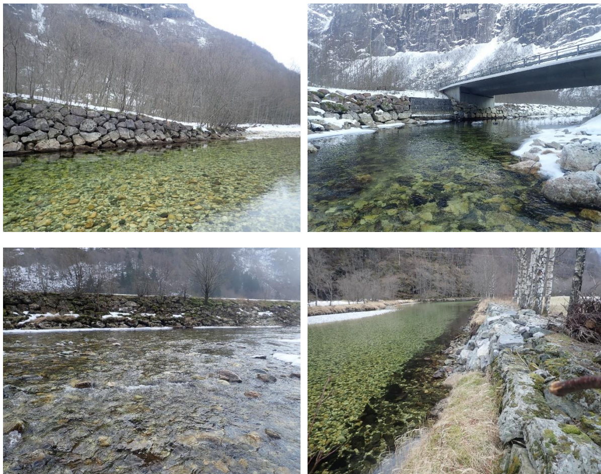
Figur 28. Erosjonssikringer langs Nærøydalselva.
