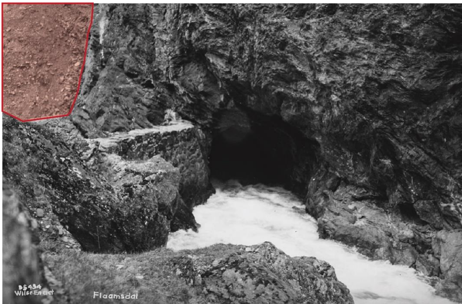
Figur 24. Tunnel for elven forbi Flåmsbanen ved Høga, ca. 1940. Bildet tyder på at jernbanedammen kan bestå av løsmasser. Kilde: nasjonalbibliothek/public domain
