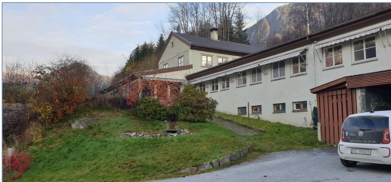
Figur 7: Bilde viser lokalitet for nytt bygg og del av eldre bygningsmasse som skal sanerast i prosessen (iVest Consult AS).
