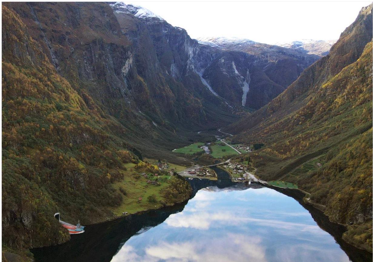
Figur 25: Fotomontasje for alternativ 2, ny innseglingkai ved Sjøskredviki, tilkomst i ny industritunnel, aust for Gudvangen (Opus)
