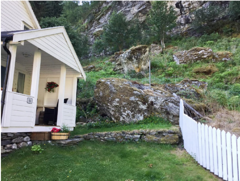
Figur 14 Flere store skredblokker fra skrenten ovenfor huset. Kun eldre utfall. Gnr/Bnr 36/30 (hus nr. 11)
