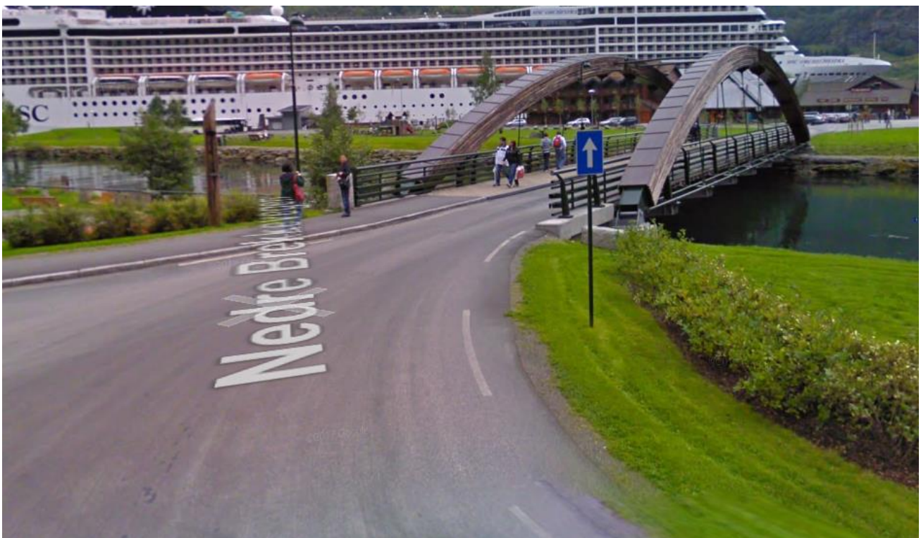
Figur 1: Innkøyring til Fretheim bru frå nordvest.
