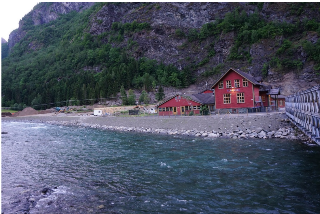
Figur 9 Flåm skole. Selve skolen ser ut til å ligge flomsikkert. Dette er et område som har svært høy hastighet. Dagens bru er midlertidig. Endelig sikring må utføres i forbindelse med ny bru. Oppbygging av elvebrinken bak forbygning er ikke kjent.
