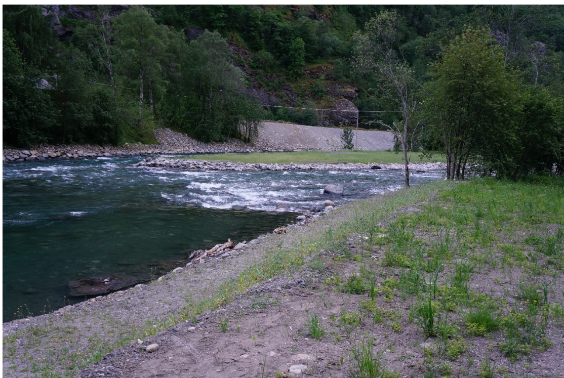
Figur 16 Øyna. Foto er tatt nedstrøms. Ved Øyna, nedstrøms Steinshølen, er østre løp hovedløp- i vestre løp er det en liten plastring. Ovenforliggende skråning er målt til 34 grader. Dvs at massene må være tørre for å kunne stå så bratt. Topp skråning ligger lengre ut etter ny veg er lagt på utsiden av den gamle.
