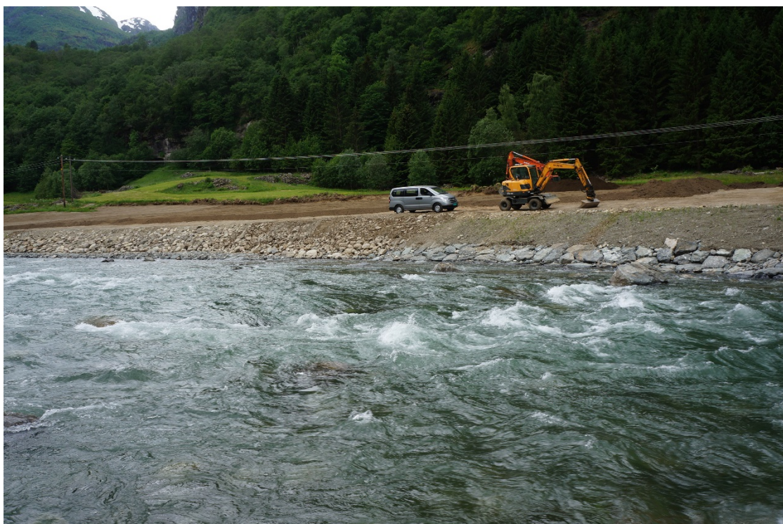
Figur 7 Oppstrøms Flåm skole. Det er etablert grovere og glattere forbygning ned mot skolen.
