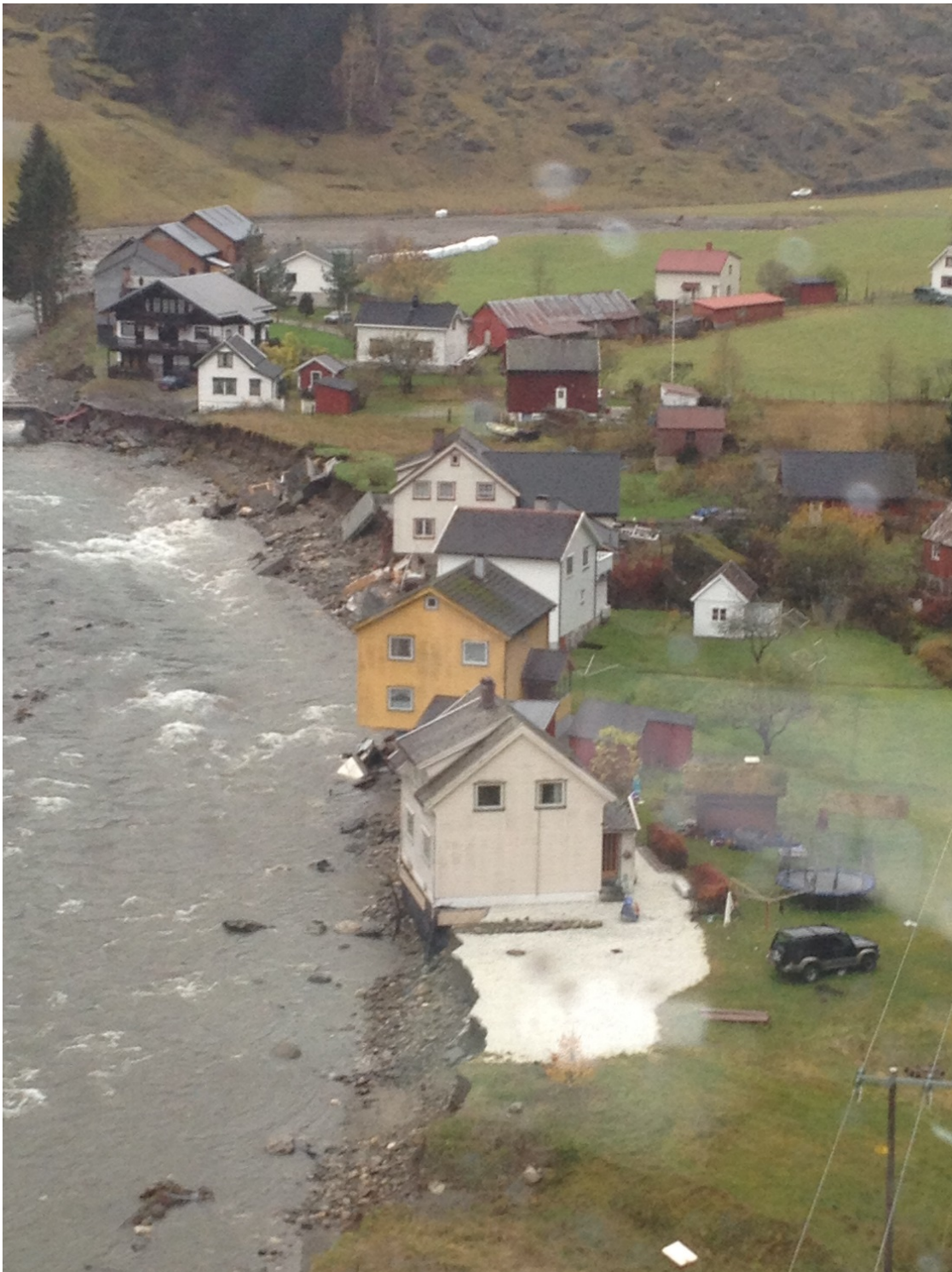
Figur 2 Bilde etter flommen i oktober 2014 nedstrøms Flåm bru. Innenfor foto er 2 hus her revet vekk, mens ytterligere 4 har fått utvasking rundt grunnmur (Foto Aurland kommune).
