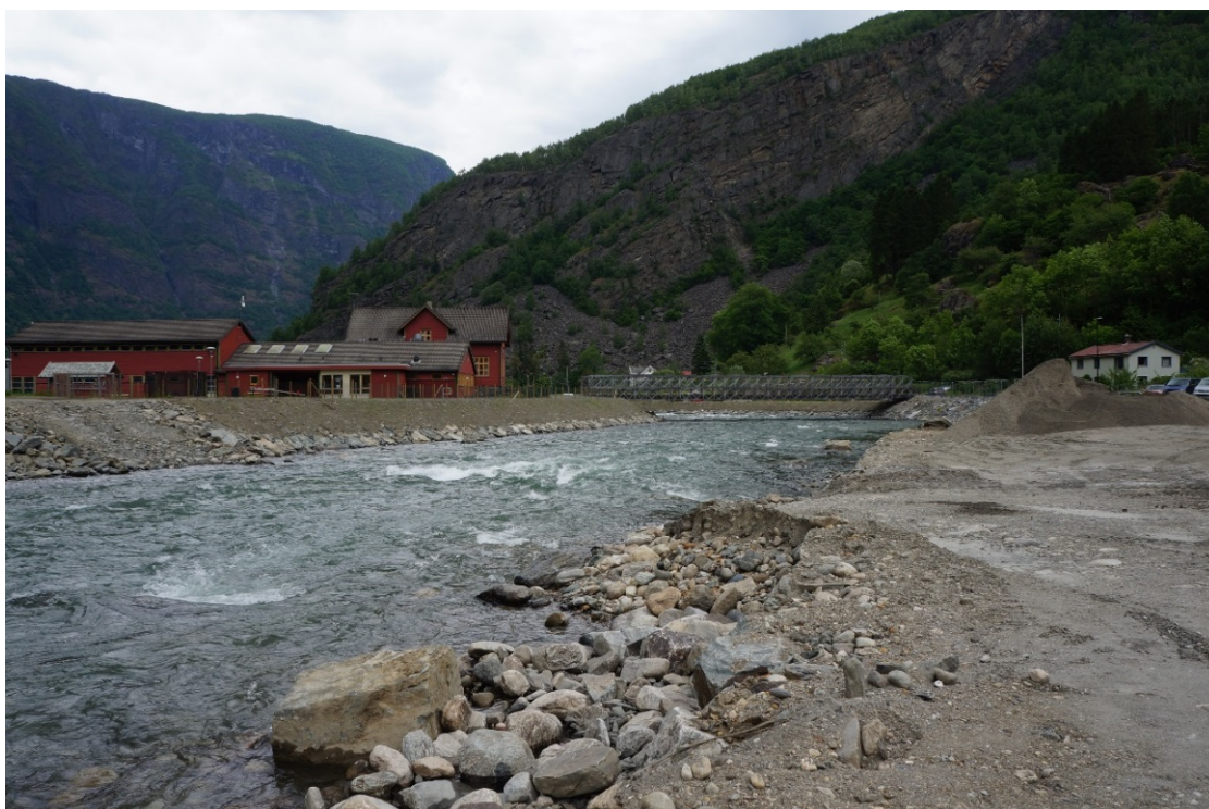
Figur 8 Oppstrøms Flåm skole. Det kommer her ny bru. Området er ikke ferdigstilt.
