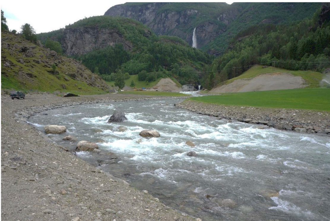
Figur 5 Sving ved Geilagrovi, der elva har betydelig fall og stor hastighet. Skråninger som raste ut i 2014 er slaket ut.
