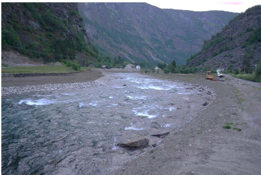
Figur 10 Sving nedenfor Flåm skole, sett nedstrøms. Svingen er her gjort mindre krapp og videre.
