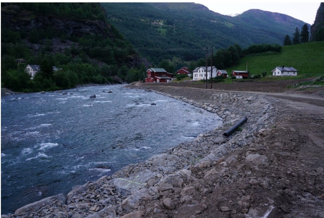
Figur 20 Oppstrøms Grindahølen. Elva gjennom Grindahølen er trang, vannet staker seg opp og strømmen går hardt på i yttersving. Forbygning sees i yttersving.
