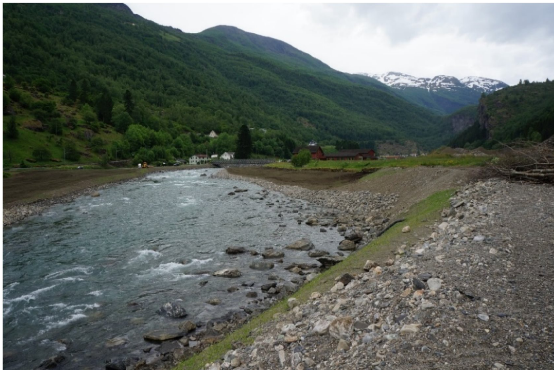
Figur 11 Nedfor skolen er elvesvingen rettet ut og elva er lagt noe mer østover. Elvekanalen har et kantete forløp forbi Brekkehagen. I dette partiet ser en det er brukt liten stein. Konsekvens av erosjon i området er vurdert som liten, men ved ekstremflom vil steinene i bildet settes i bevegelse. Foto er sett oppstrøms.
