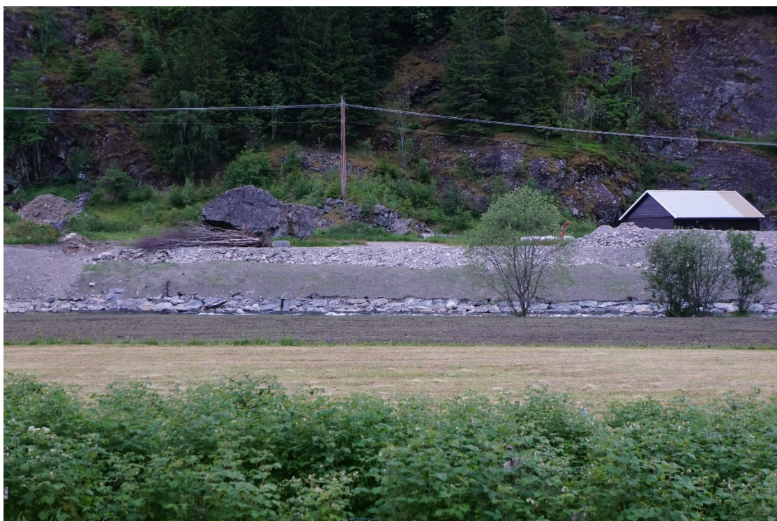
Figur 12 Ved Brekkehagen er det er lagt ut masse for vegetering som er vasket vekk. Figur 13 viser at det her var vannføring på ca. 100-110 m 3 /s i starten av juni, 2016. Dette er noe lavere enn årsmiddelflom, og demonstrerer at det er vanskelig å etablere vegetasjon lavere enn middelflom vannstand. I henhold til Figur 13 var vannføringen ca 40 m 3 /s ved befarings 15. juni, 2016.
