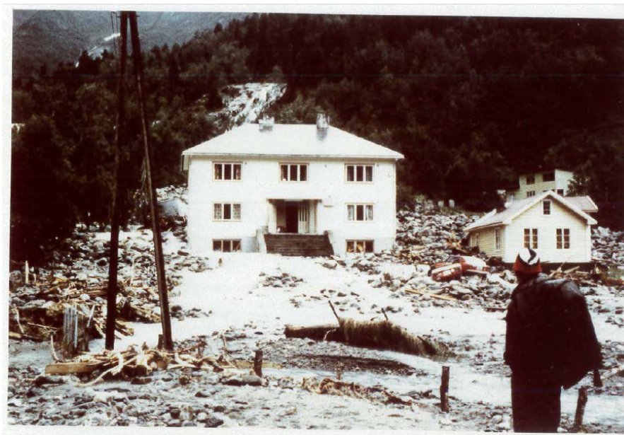
Bildet viser Sagarøy, 1979. Jostedal herredshus hvor kjelleren ble fylt med stein. Foto Nic Barton.
