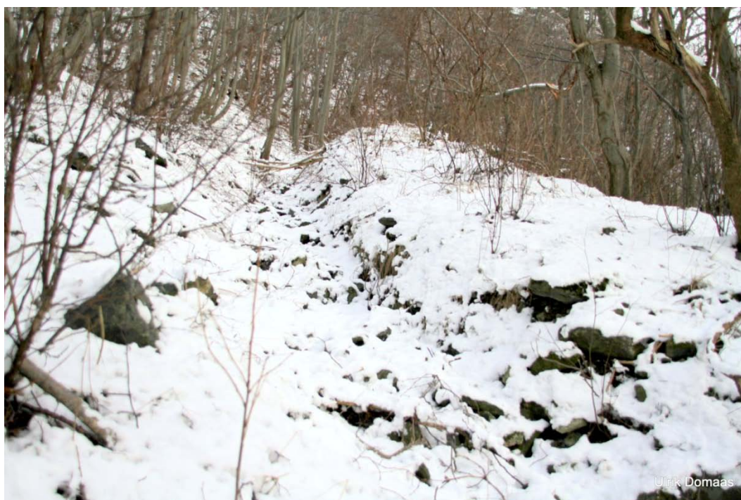
Figur 13. Ovenfor boligfeltet i Flåm er det laget en grøft som er rundt en meter dyp. Denne kan til dels lede vann og mindre flomskred.
