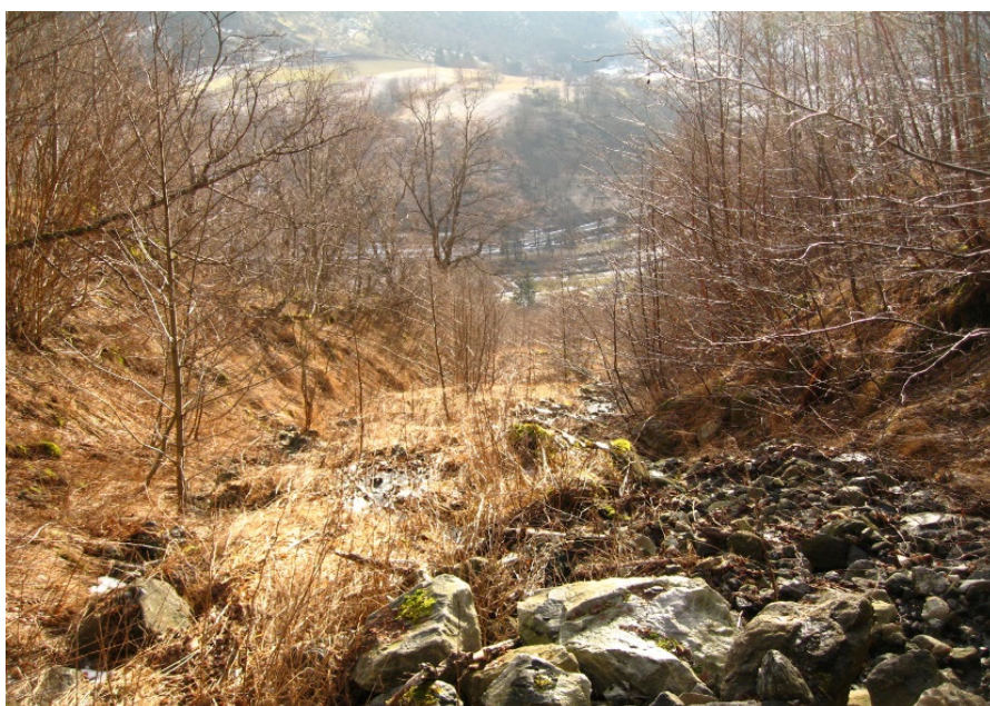
Figur 9 Bildet viser kanalen som vann og skred har gravd ut nedstrøms Haragjuvet.
