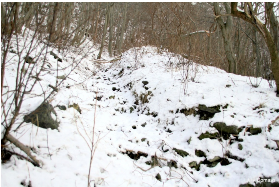
Figur 10 Ovenfor boligfeltet lengst øst i Flåm er det laget en grøft som er rundt en meter dyp. Denne kan lede vann og mindre flomskred.
