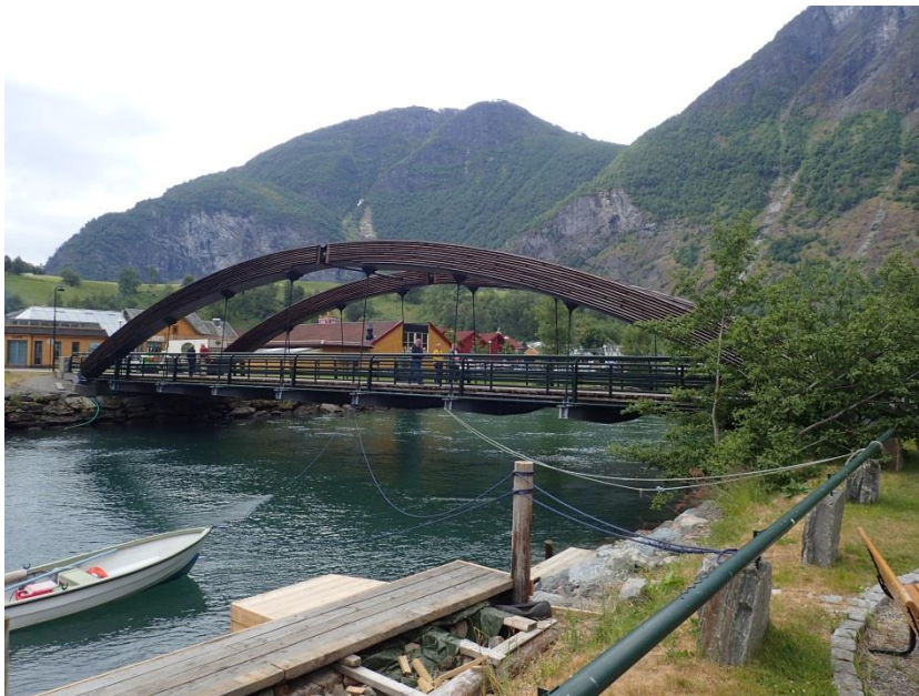
Figur 3-9. Bro ved utløpet til fjorden (profil 4714)
