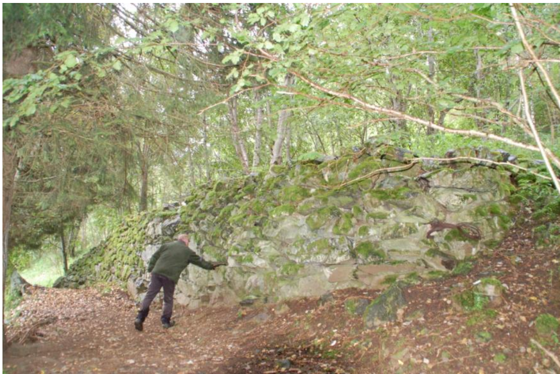
Figur 10 Høg mur i Heimstallid. Truleg har muren fungert som ein kombinert bakkemur og vegmur for ein tidlegare vegtrasé (pers. med. Arild Dyrdal).
