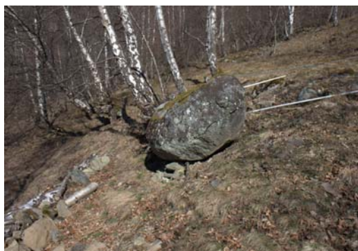
Foto 4. Blokk festa med wire og Foto 5. Blokk med rullehindring.
