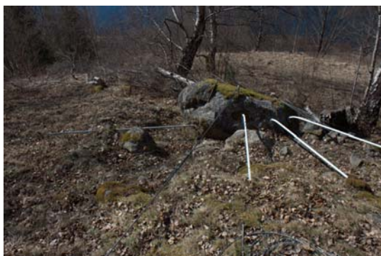
Foto 4. Blokk festa med wire og Foto 5. Blokk med rullehindring.
