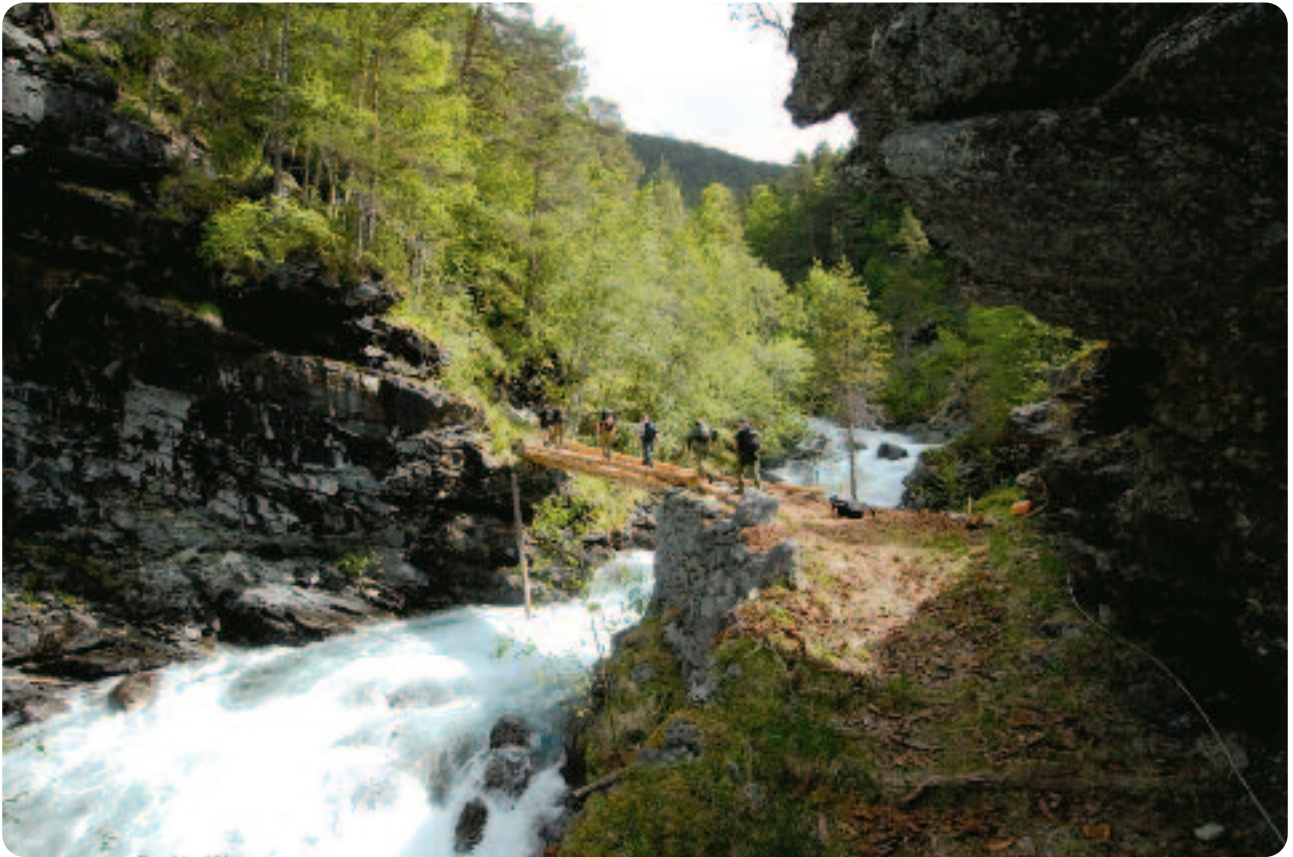
Den nyreparerte brua over hovudelva i Nordheimsdalen. Foto: Jon Erling Skåtán
