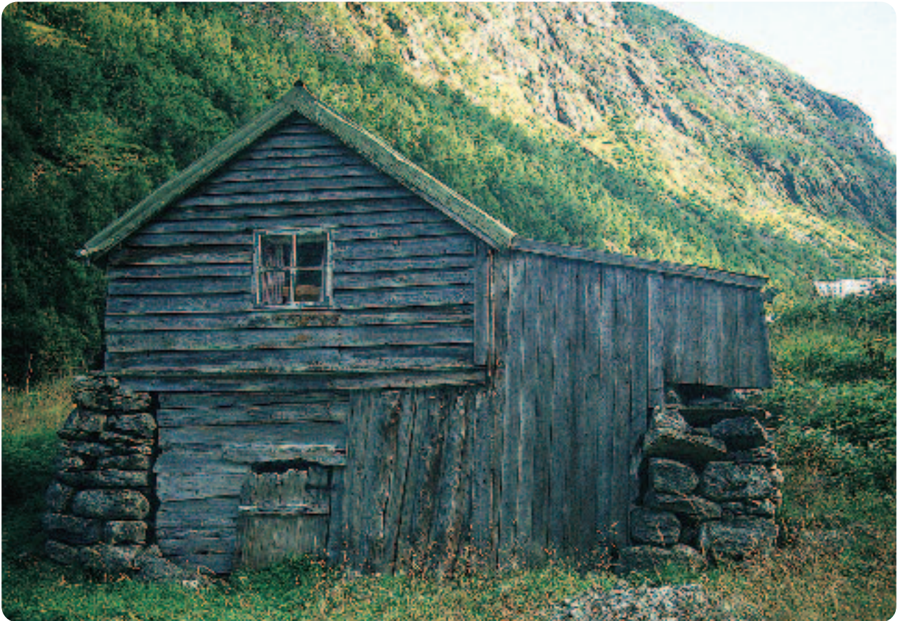
Det er viktig å ta vare på bygningsmiljøet, som dette selet på Hjøльмо i Dyrdal. Foto: Tom Dybwad
