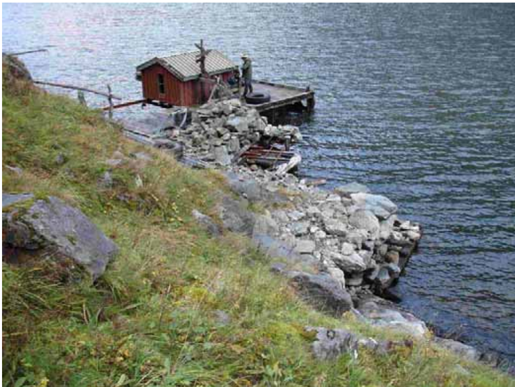
Figur 27 Kaia. Tidlegare steinkai låg til høgre for den vesle trekaia. Her er trong for ny tilrettelegging. Foto: Tom Dybwad.
