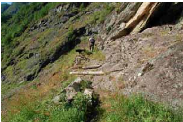
Figur 12 Stokkar og vaier til å halde seg i for å unngå å gli på is eller glatt sva.
