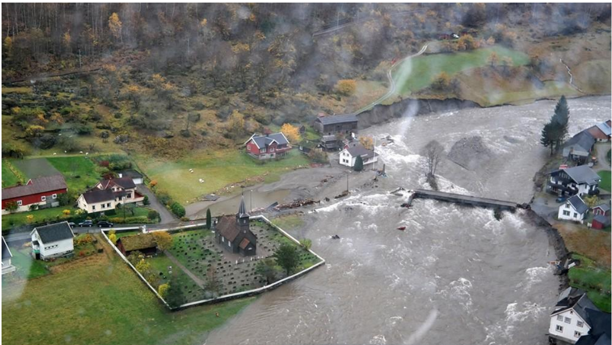
Figur 1 Bilde av Flåmsbrua etter at flomtoppen har passert. Flere bygninger er vasket bort gjennom elvens erosiv kraft (Foto: Oddleif Løset, NRK)
