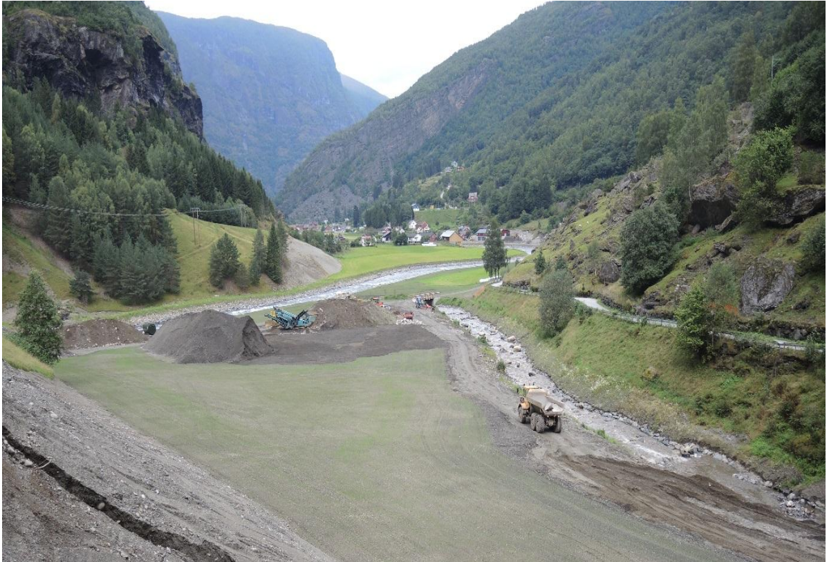
Figur 17 tatt høsten 2016. Flytting av Tverrelvi (like oppstrøms foregående bilder) og nye adkomstveier med skråninger og steinplastring
