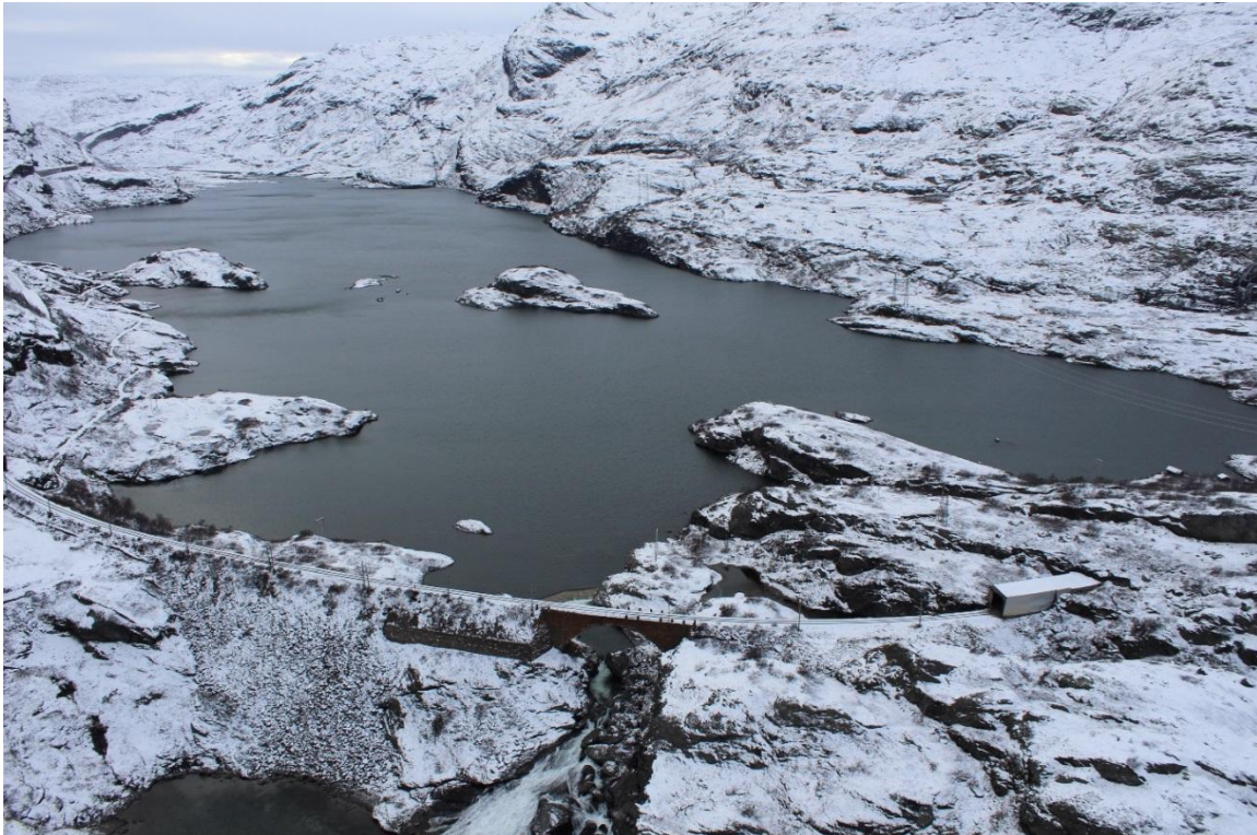
Figur 4 Klevevatn magasin sett mot sør om høsten med dammen som skimtes like bak jernbanebrua
