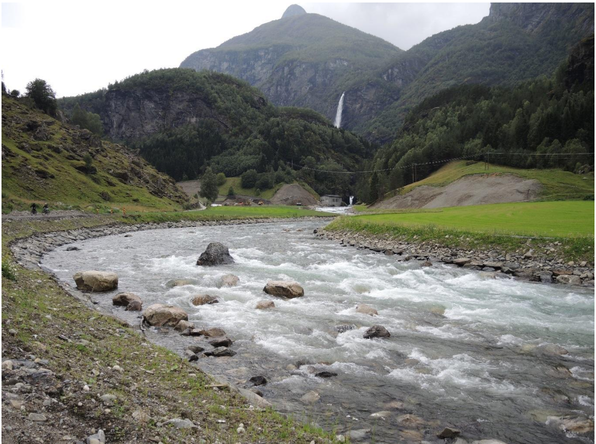
Figur 18 tatt høsten 2016. Ferdigstilt plastring sett oppover mot Leinefossen
