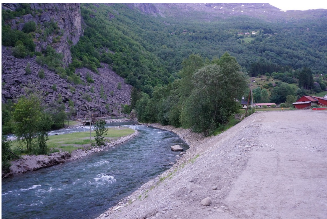
Figur 17 Øyna sett oppstrøms. Til høyre, nærmest fotografen, sees en bratt utvidet fylling mot elva. Skråningen er utsatt for rilleerosjon på overflaten fra lokal nedbør inntil skråningen gror igjen.
