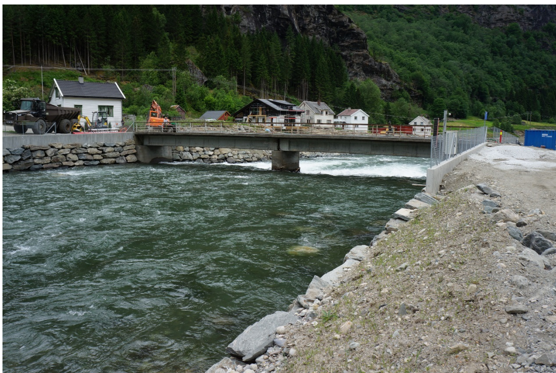
Figur 6 Flåm bru. Brua har fått solid bunnterskel. Det er flomvei øst for brua, og nytt vannmerke er etablert. Bruas kapasitet er ikke beregnet.
