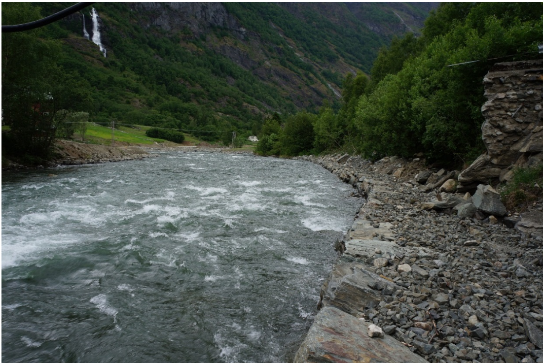
Figur 19 Ved brukaret til Brekke bru. Elva har fått ny forbygning for å holde strømmen unna skråningsfoten.
