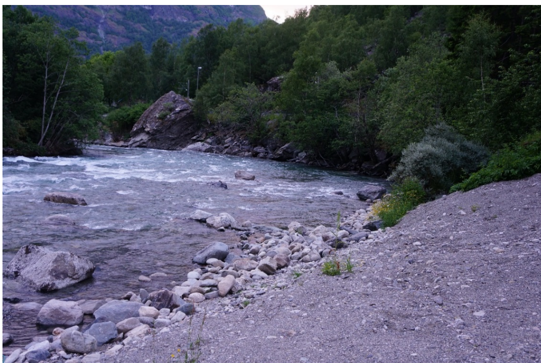
Figur 18 Sving ovenfor der Brekke bru fantes før 2014(vekk). Mye grove masser og stor stein sees i elvekanten, men vegkanten (i forkant) er stedvis svak og i bevegelse.
