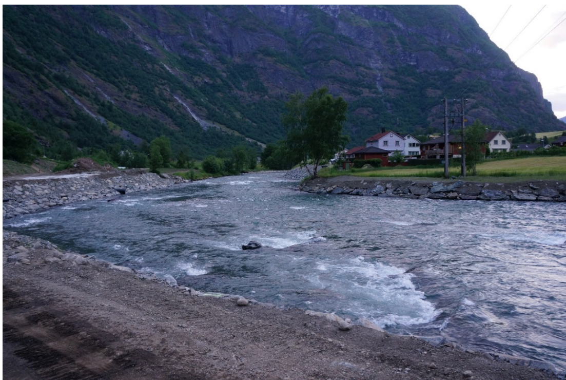
Figur 21 Gjennom Grindahølen sett nedstrøms. Begge bredder er plastret med stor stein etter stor erosjon.
