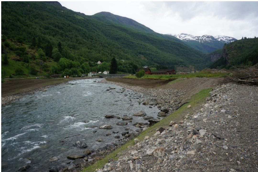
Figur 11 Nedfor skolen er elvesvingen rettet ut og elva er lagt noe mer østøver. Elvekanalen har et kantete forløp forbi Brekkehagen. I dette partiet ser en det er brukt liten stein. Konsekvens av erosjon i området er vurdert som liten, men ved ekstremflom vil steinene i bildet settes i bevegelse. Foto er sett oppstrøms.
