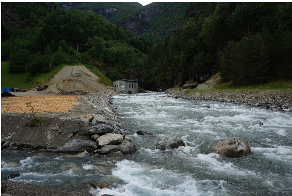
Figur 4 Leina kraftstasjon. Elva har her sitt bratteste parti. (Foto tatt oppstrøms)
