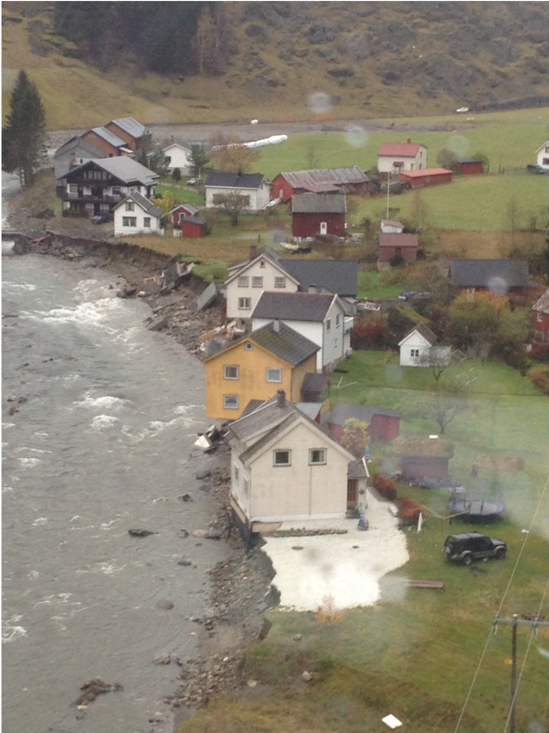
Figur 2 Bilde etter flommen i oktober 2014 nedstrøms Flåm bru. Innenfor foto er 2 hus her revet vekk, mens ytterligere 4 har fått utvasking rundt grunnmur (Foto Aurland kommune).
