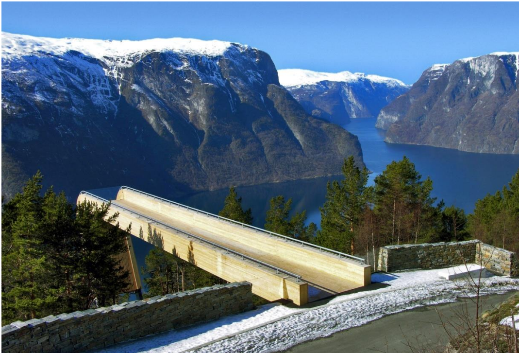
(Foto: Bjørn Andresen, Statens Vegvesen)
