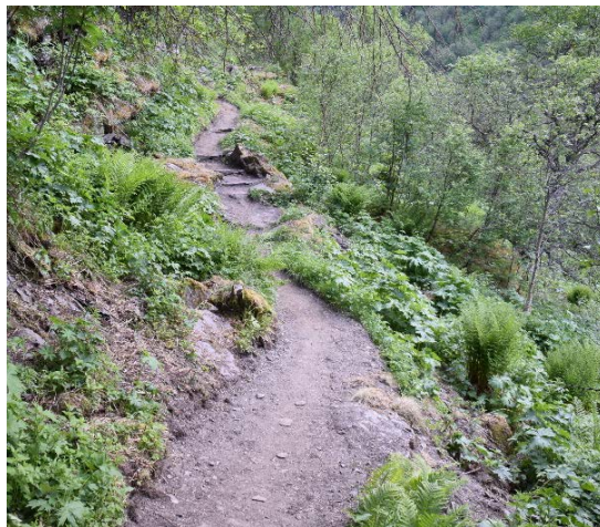
Figur 7. Utan jamleg vedlikehald, forsvinn grusdekket på vegen. Biletet til høgre visar god standard etter vedlikehald både murar, stikkrenner og toppdekke (Sinjarheimshagen).
