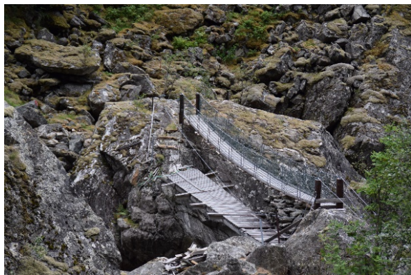
Figur 8. Ny bru over elva ved Almen. Den gamle vart øydelagt av steinsprang. Til høgre, Mellombels farbar veg er oppretta etter det store raset i Kraokegjelet.
