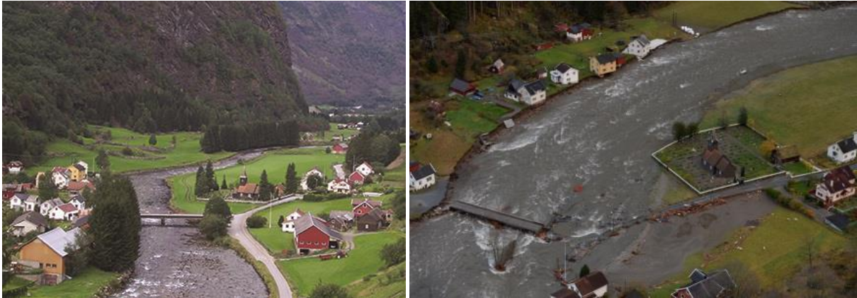
Flommen i Flåmselva høsten 2014 førte til store ødeleggelser. Flere hus gikk tapt, blant annet den røde låven som ses foran i bilde fra før flommen. Flåm kirke fikk vannskader da den middelalderiske kirkegården ble oversvømt.. Foto: Til venstre før flommen Andrew Bowden, Wikimedia Commons. Foto til høyre under flommen: Helge Mikalsen/VG/NTB scanpix.
